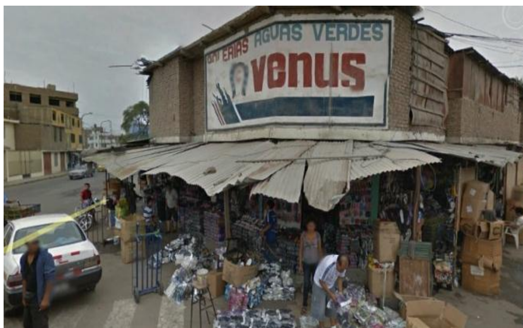
Foto 33. Estado actual del mercado Aguas Verdes.
