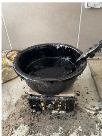
Ilustración 47: Calentado del bitumen
