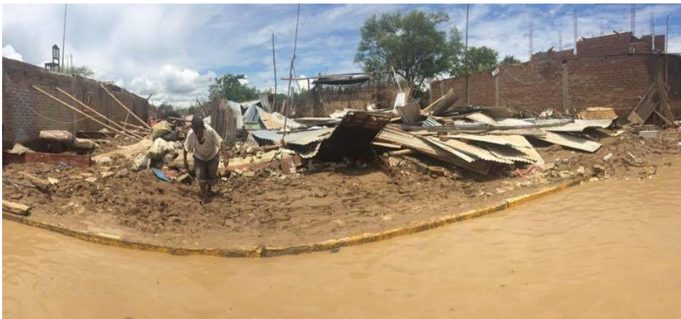
Figura 2. Viviendas afectadas por las lluvias, Íllimo.
