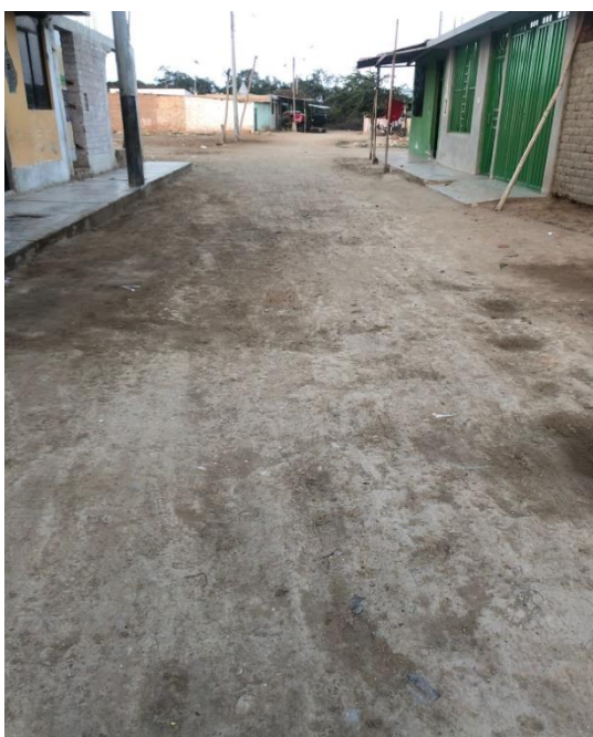
Figura 4. Vías en el distrito de Íllimo sin pavimentar.
