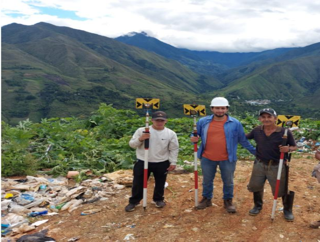
Foto N°5: Listos para el levantamiento topográfico con la estación total y primas correspondientes
