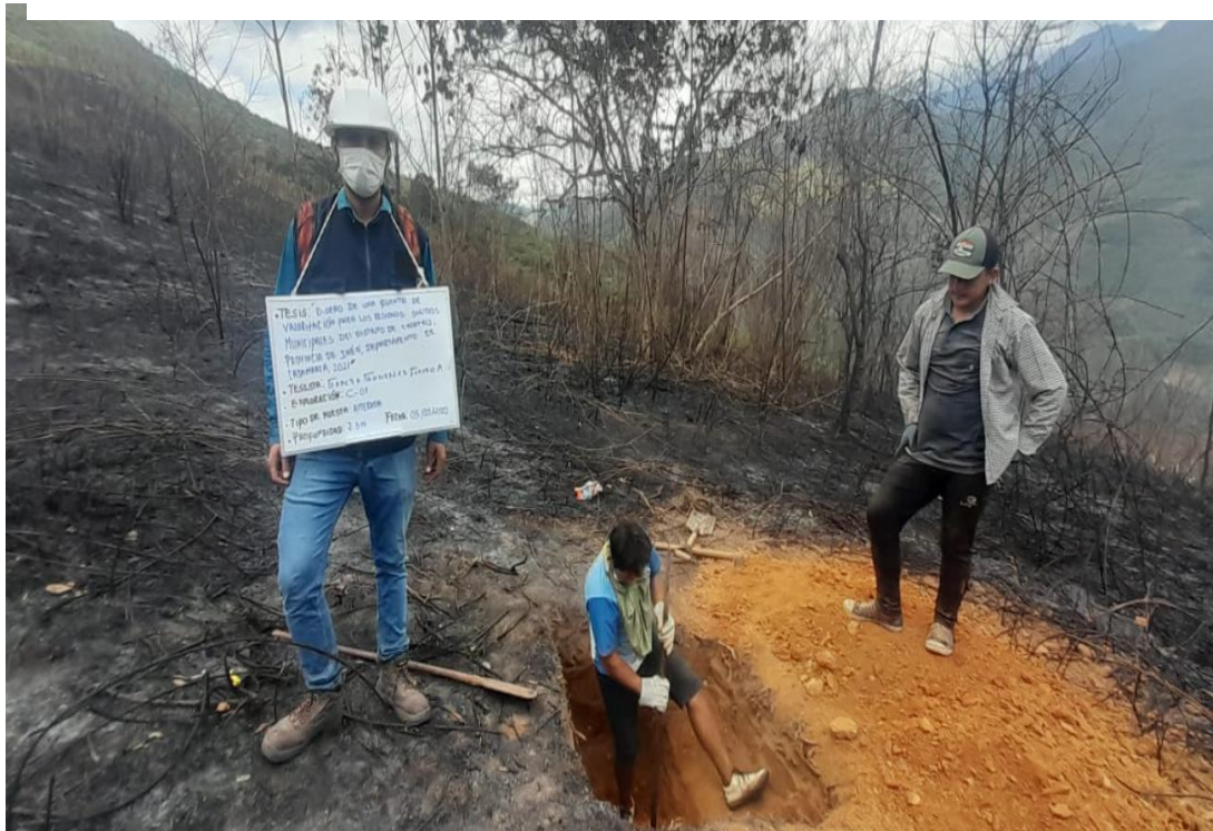
Foto N°8: Calicata N°1 – Estudio de mecánica de suelos.
