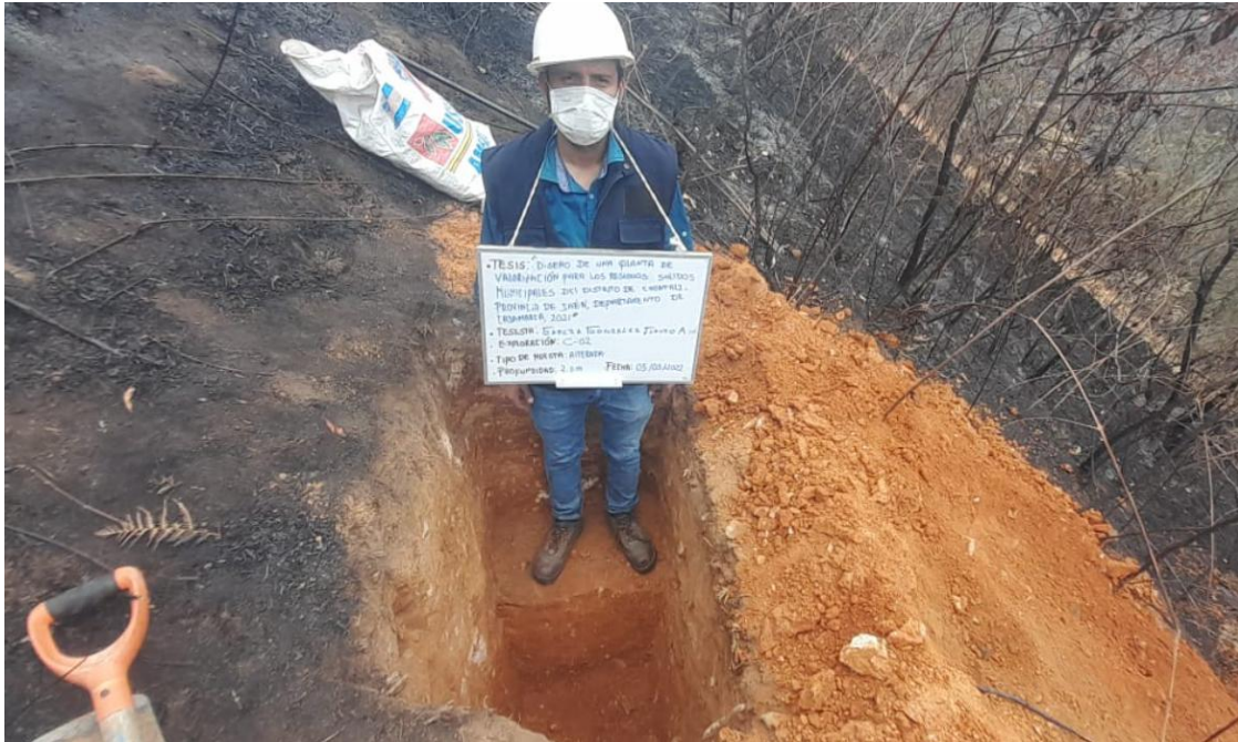
Foto N°9: Calicata N°2 – Estudio de mecánica de suelos.
