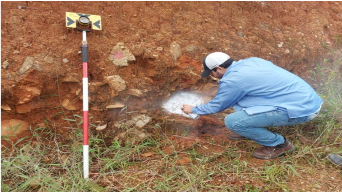
Foto N°6: Fijación de uno de los puntos BM – Estudio topográfico
