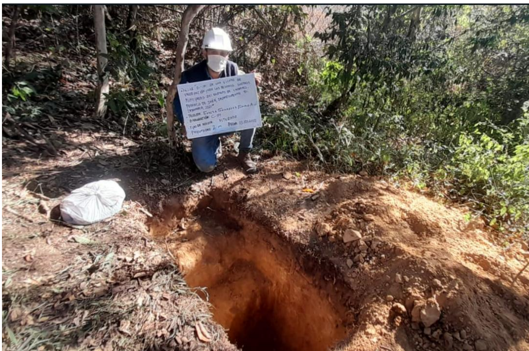
Foto N°11: Calicata N°4 – Estudio de mecánica de suelos.
