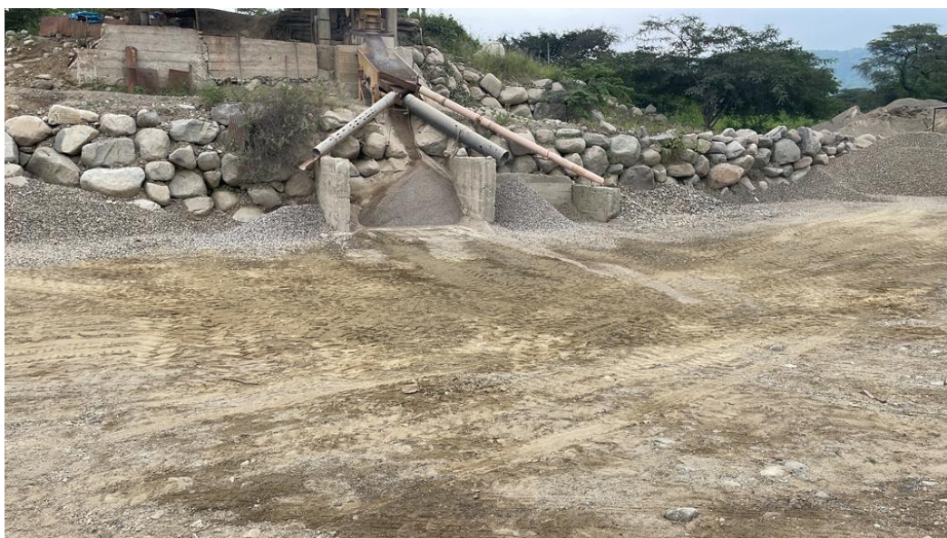
Ilustración 12: Proceso de trituración en chancadora chuzón
