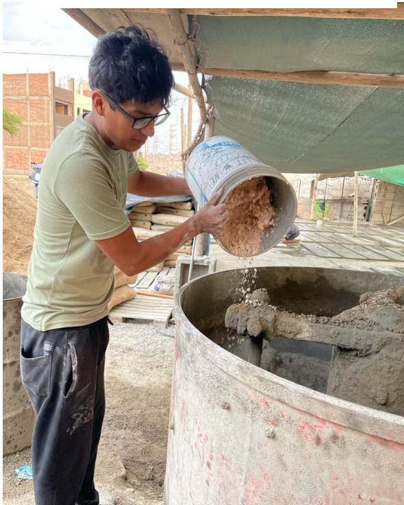
Ilustración 98: Adición del 5% de diatomita
