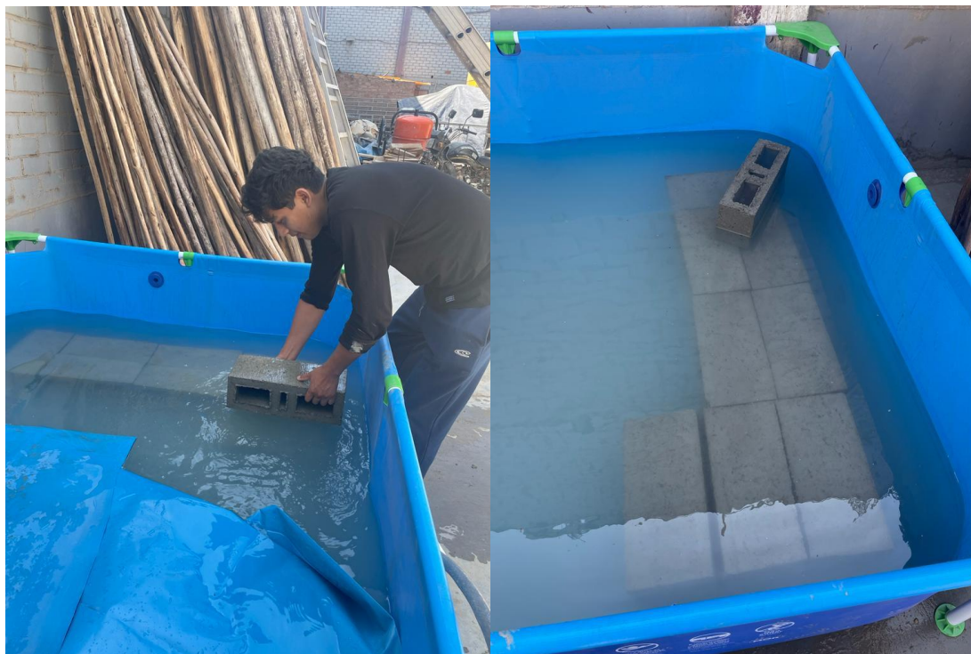
Ilustración 101: Curado de los bloques
