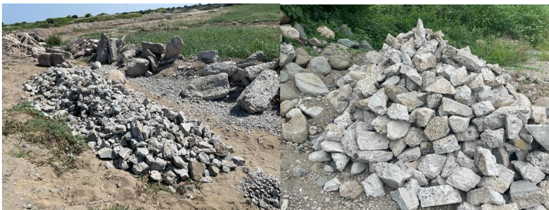
Ilustración 11: Volumen de residuo de demolición de concreto
