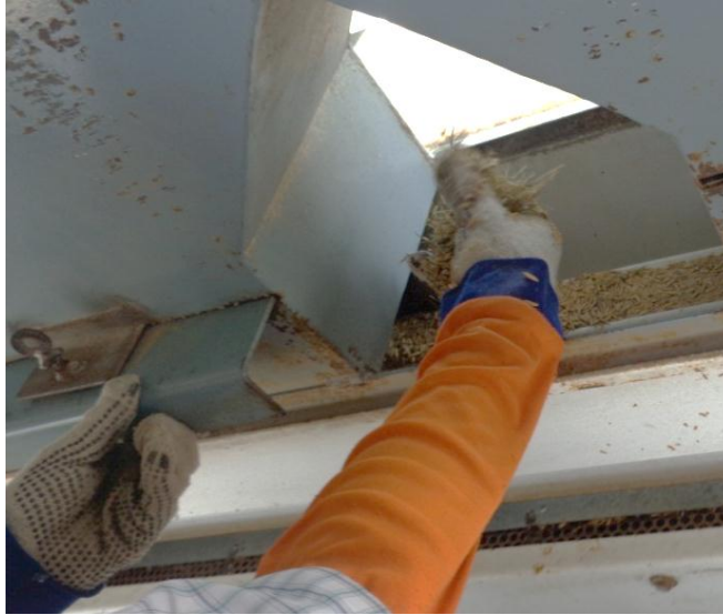
Figura 22: Limpieza manual de impurezas en tolvas de zarandas
