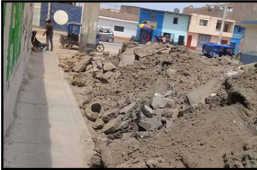
Ilustración 52: Recolección de la carpeta asfáltica Fuente propia
