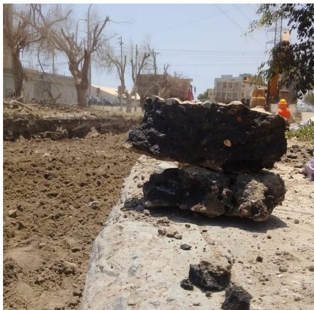
Ilustración 9: Recolección de la Carpeta Asfáltica removida de la calle Los Tréboles Fuente: Propia
