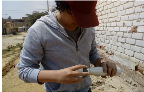
Fig. 1. Preparación para ensayo de esclerometría
