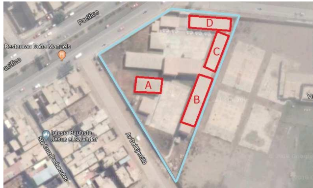
Fig. 22. Vista aérea de pabellones de I.E. 10030 Naylamp.
