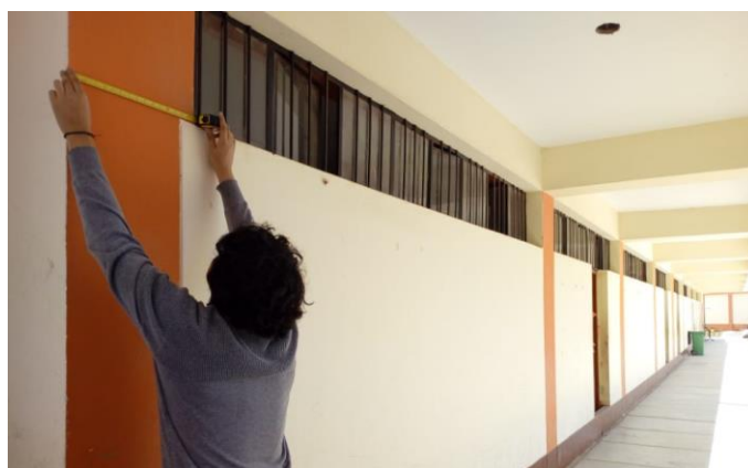
Fig. 12. Levantamiento de los elementos estructurales de la I.E. 10030 Naylamp
