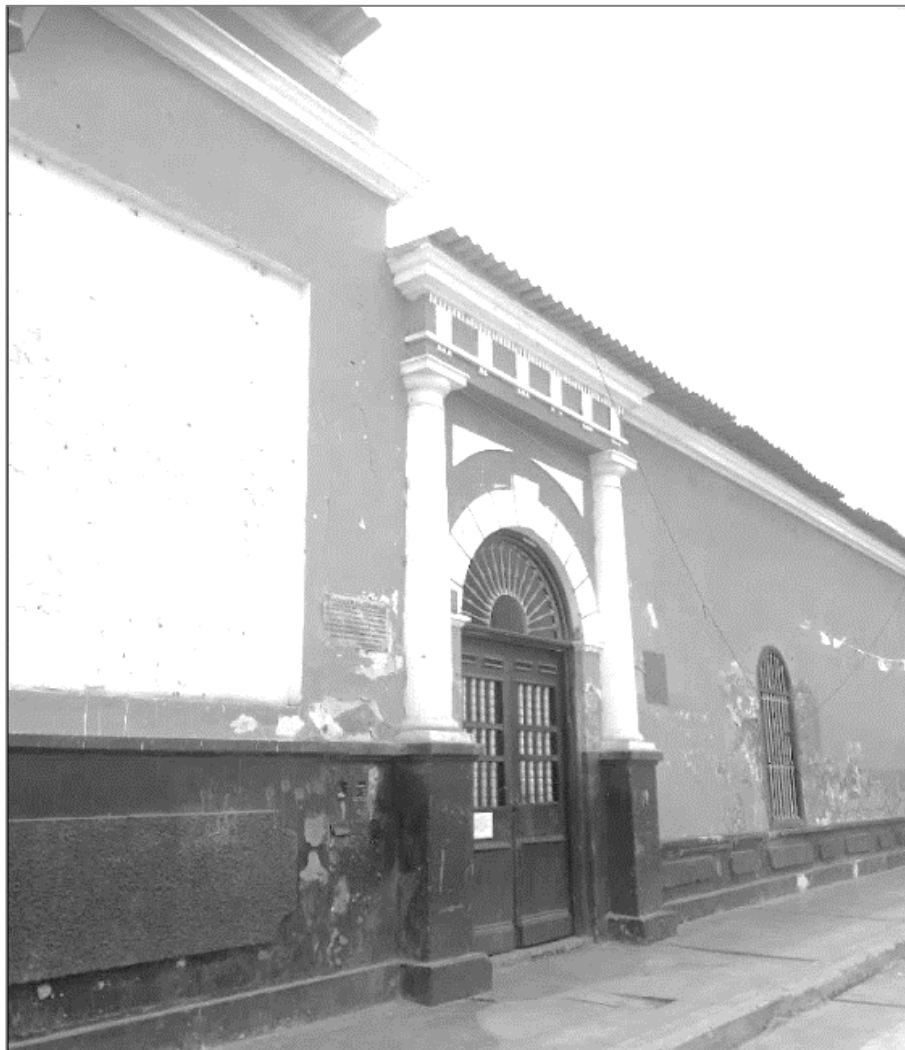
Figura 24: Fachada principal del monumento, elaboración propia
