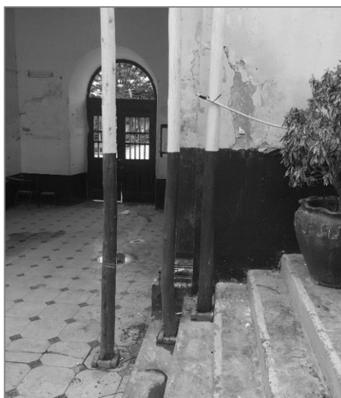
Figura 26: Patio I vista al zaguán, elaboración propia
