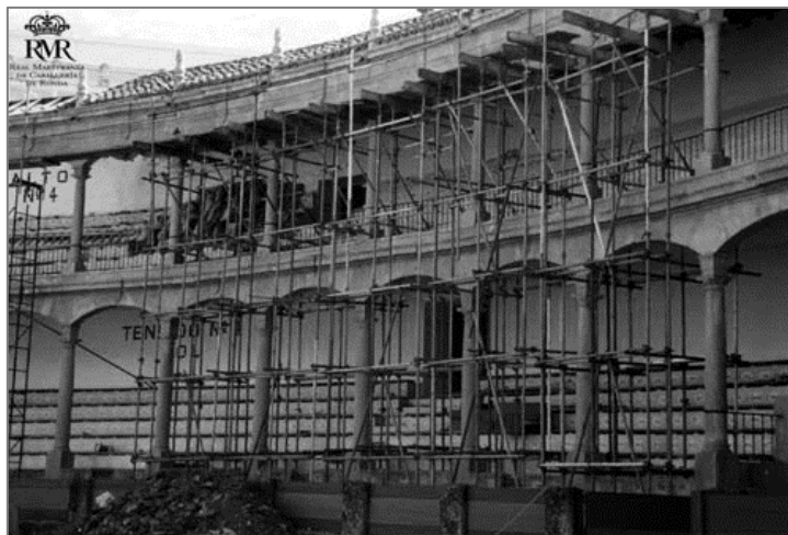
Figura 7: Proceso de reestructuración de la estructura Conjunto de la Plaza de Toros de Ronda. Fuente fotográfica: RMR
