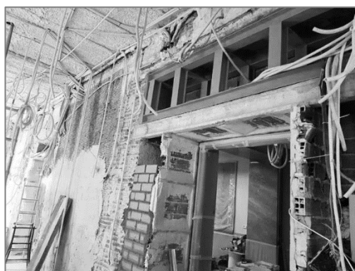
Figura 6: Proceso de consolidación y refuerzo de un muro a través de puntales y corte de codales
