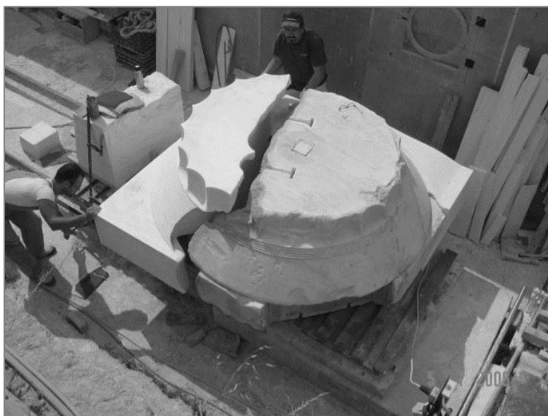
Figura 9: Proceso de integración del basamento de una columna Romana
