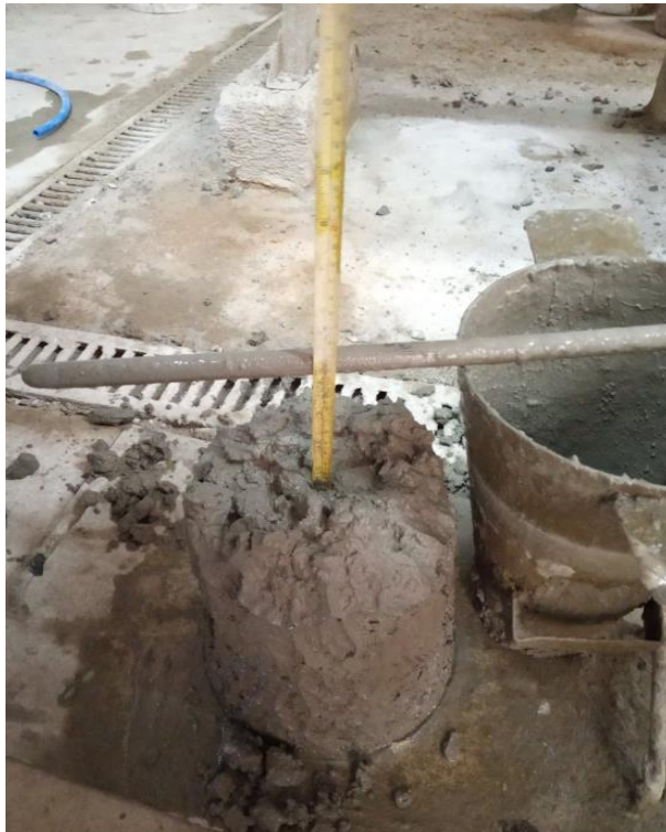
Ilustración N° 14: Prueba de asentamiento
