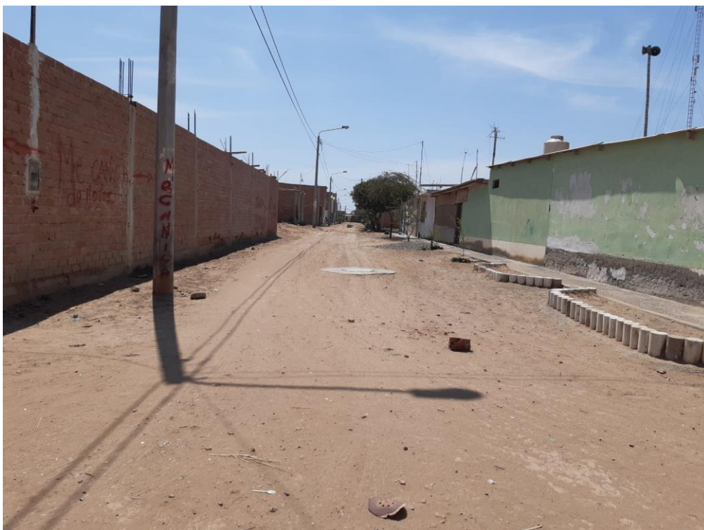
Fotografía 8 Situación Actual de la Calle 3
