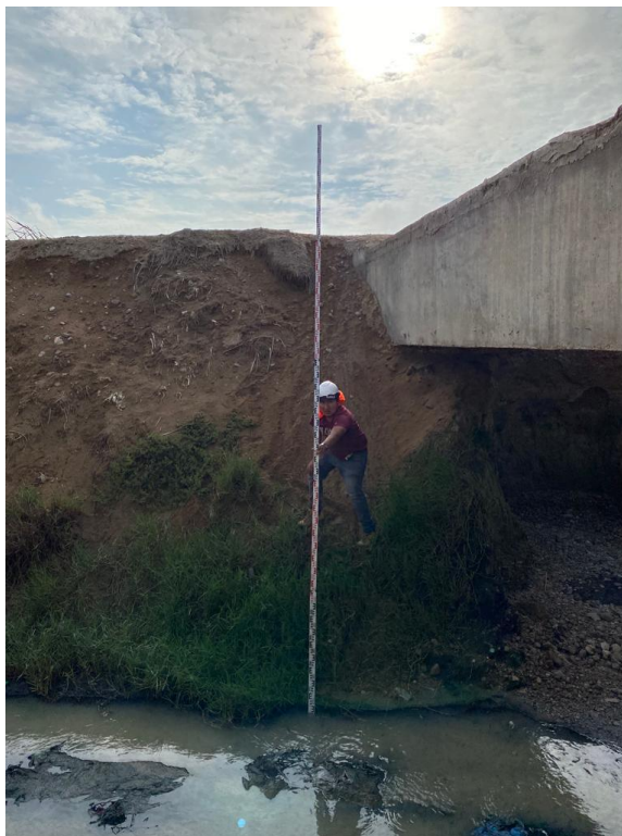
Fotografía 27 Visita in situ del Dren 3000
