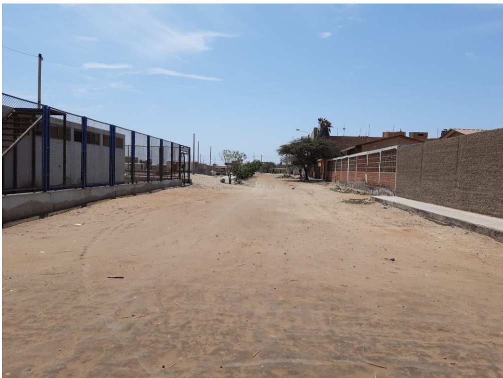
Fotografía 1 Situación Actual de la Calle 2
