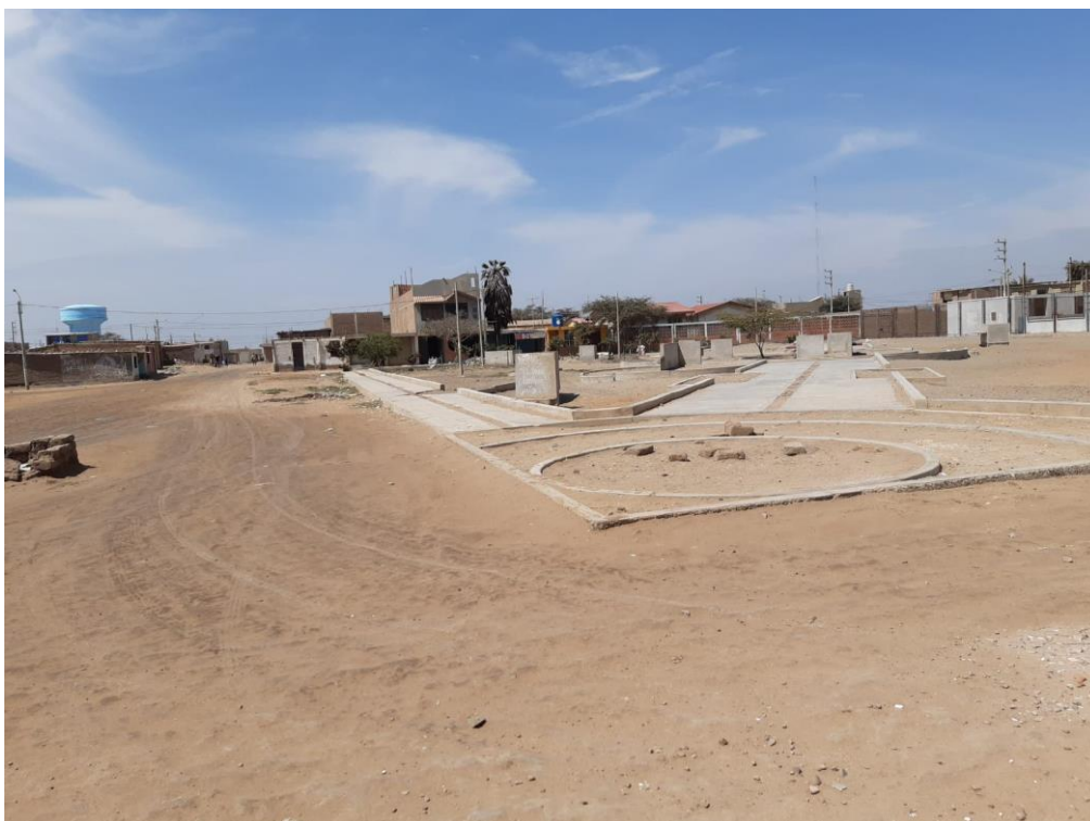
Fotografía 7 Situación Actual de la Calle 19
