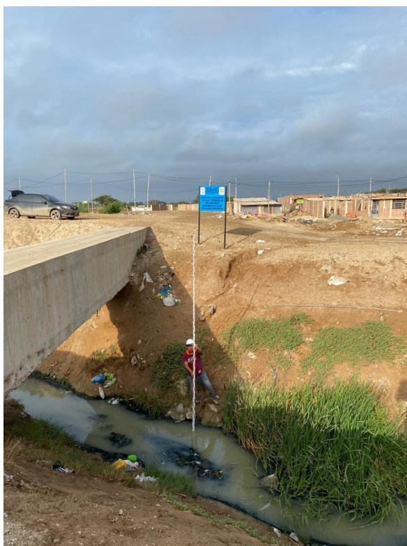
Fotografía 28 Visita in situ del Dren 3000
