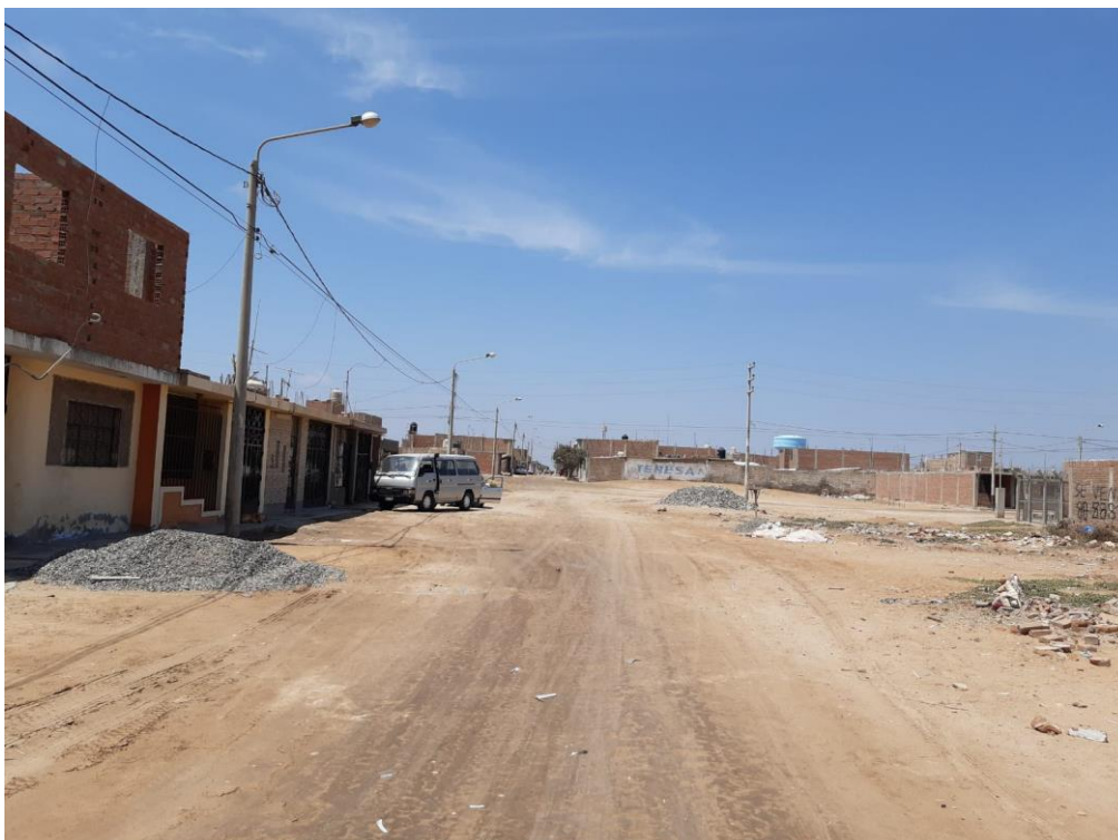
Fotografía 2 Situación Actual de la Calle 8
