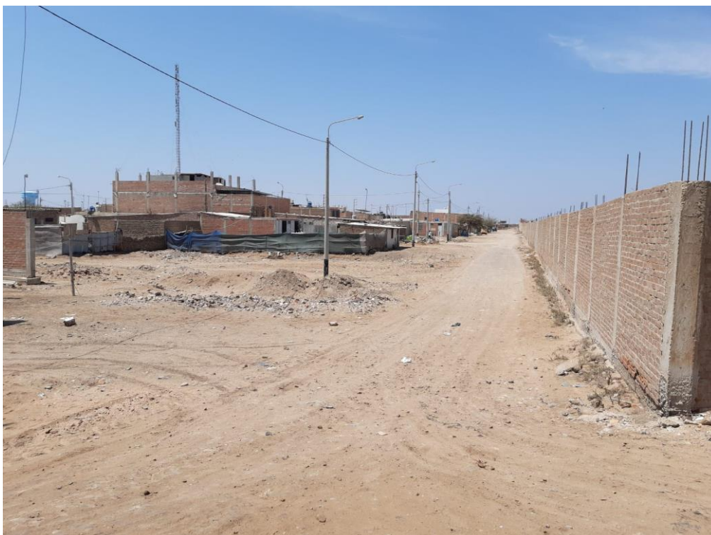
Fotografía 4 Situación Actual de la Avenida E
