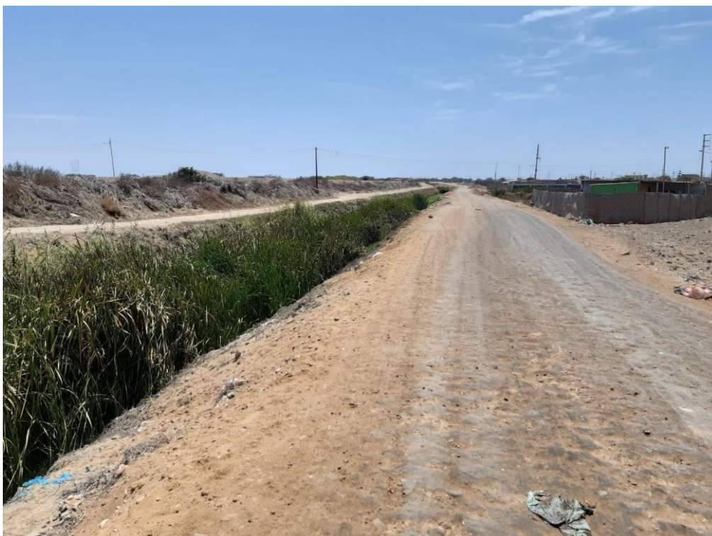
Fotografía 5 Situación Actual de la Calle 5
