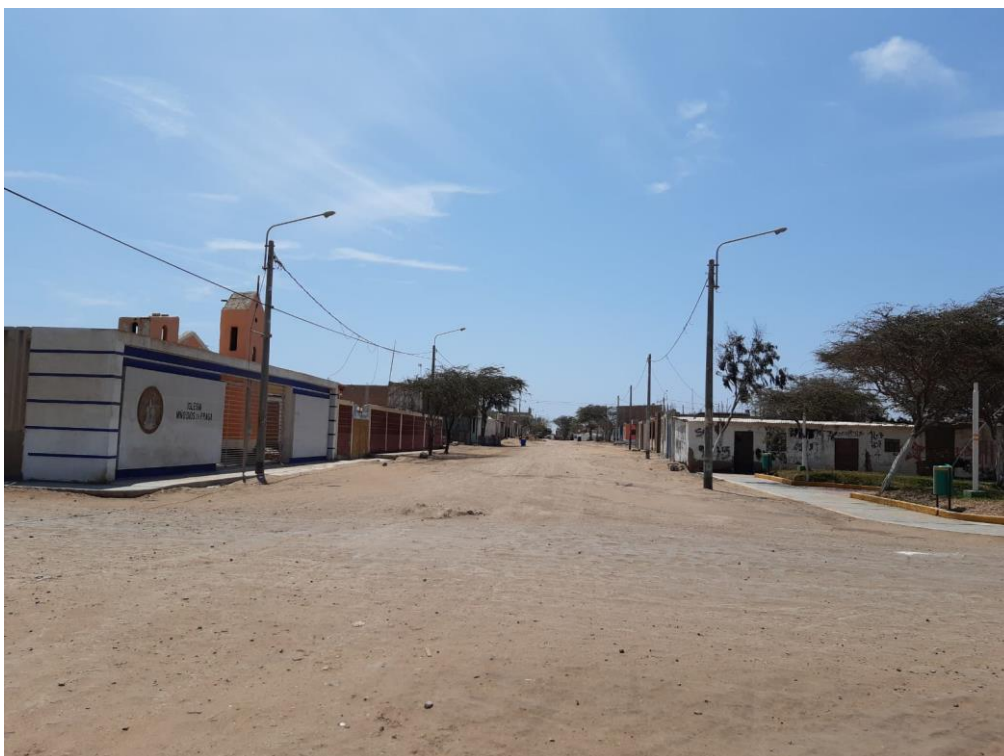
Fotografía 3 Situación Actual de la Calle 1
