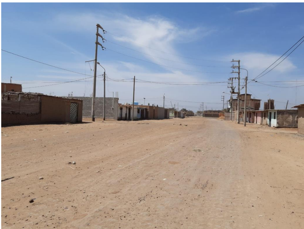
Fotografía 6 Situación Actual de la Avenida C
