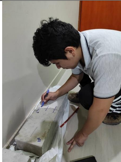
Figura 78: Tesista marcando viga fisurada para controles respectivos.
