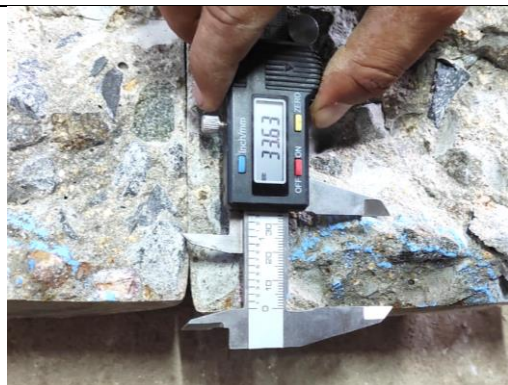
Figura 104: Distancia más lejana que el agua logra penetrar en el concreto patrón (1A).
