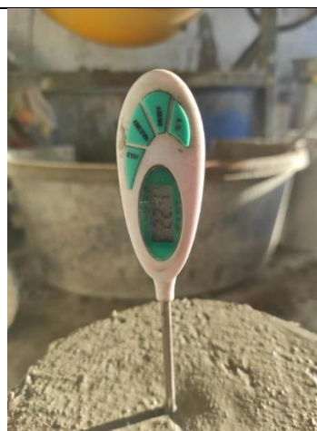
Figura 56: Control de temperatura de concreto patrón.
