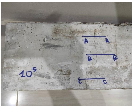
Figura 130: Viga de bioconcreto 1 \times 10^5 cel/ml fisurada, antes.
