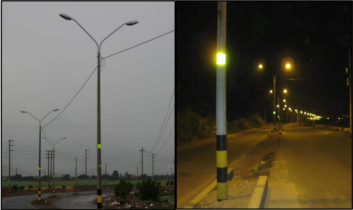
Fotografica N°03: Tomas fotograficas Obra Culminada: “Suministro, Transporte, Montaje Pruebas y Puesta en Servicio de la Obra Alumbrado Público Vía enlace Distritos de Laredo y El Porvenir”
