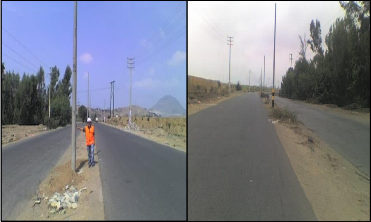
Fotografica N°01: Izaje de postes de Alumbrado Público, Obra: “Suministro, Transporte, Montaje Pruebas y Puesta en Servicio de la Obra Alumbrado Público Vía enlace Distritos de Laredo y El Porvenir”
