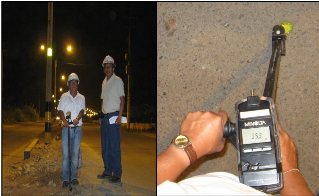
Fotografica N°04: Pruebas de Iluminación, Obra: “Suministro, Transporte, Montaje Pruebas y Puesta en Servicio de la Obra Alumbrado Público Vía enlace Distritos de Laredo y El Porvenir”
