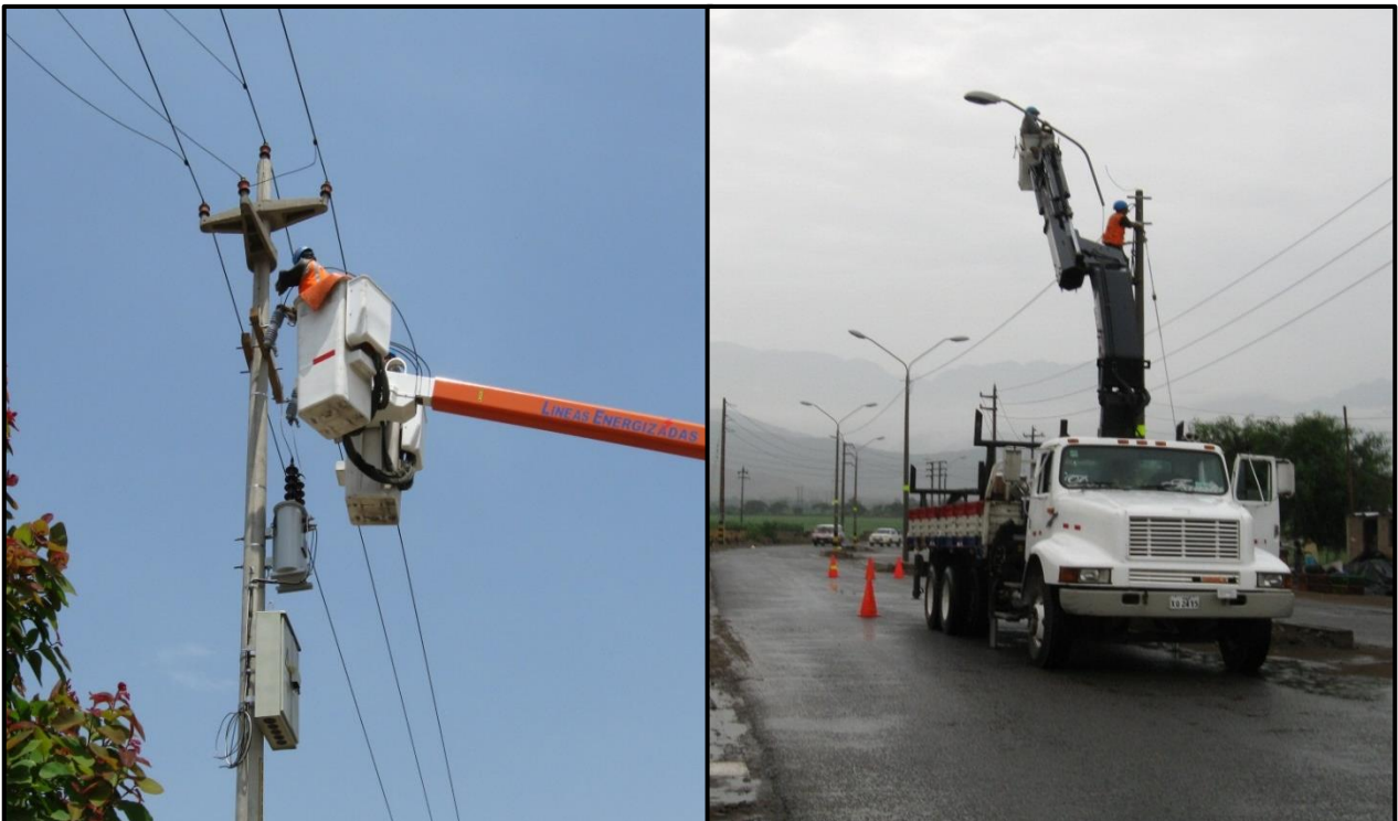
Fotografica N°02: Instalación de Subestaciones y Artefactos de Iluminación, Obra: “Suministro, Transporte, Montaje Pruebas y Puesta en Servicio de la Obra Alumbrado Público Vía enlace Distritos de Laredo y El Porvenir”
