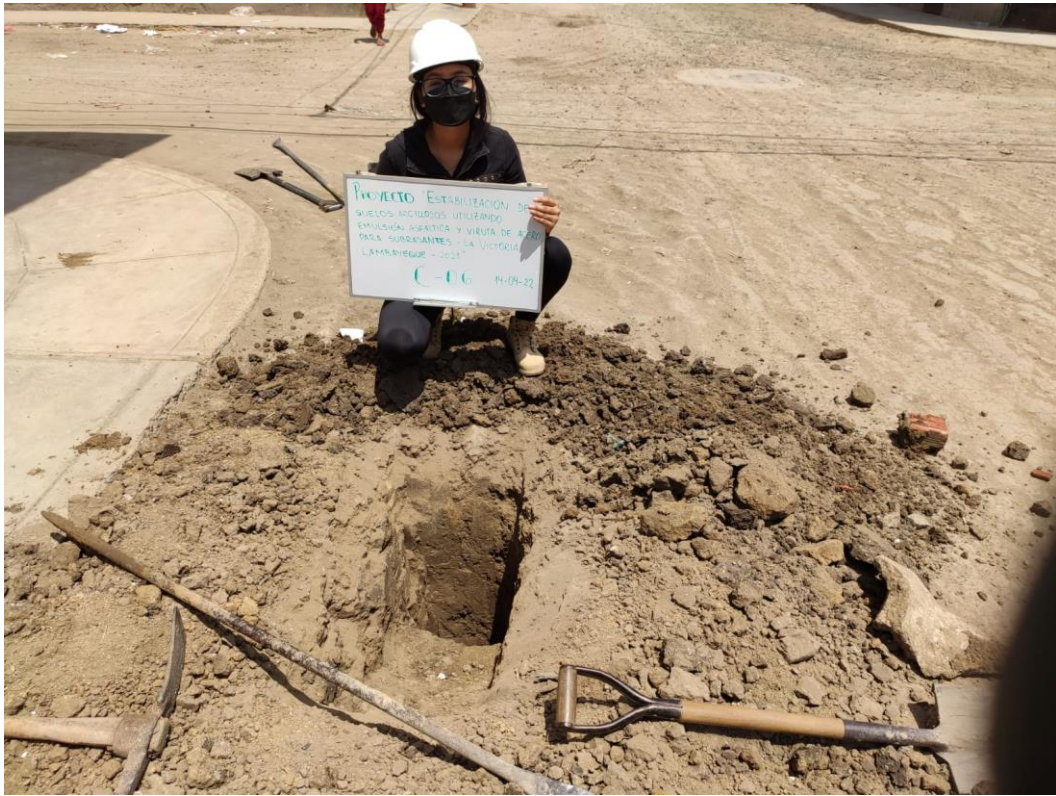
Fotografía XI: Excavación de calicata 06.
