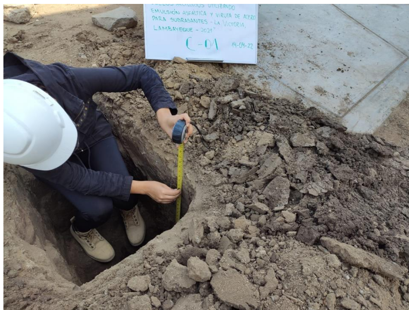
Figura 2: Medición de profundidad de calicatas. Fuente: Elaboración propia.
