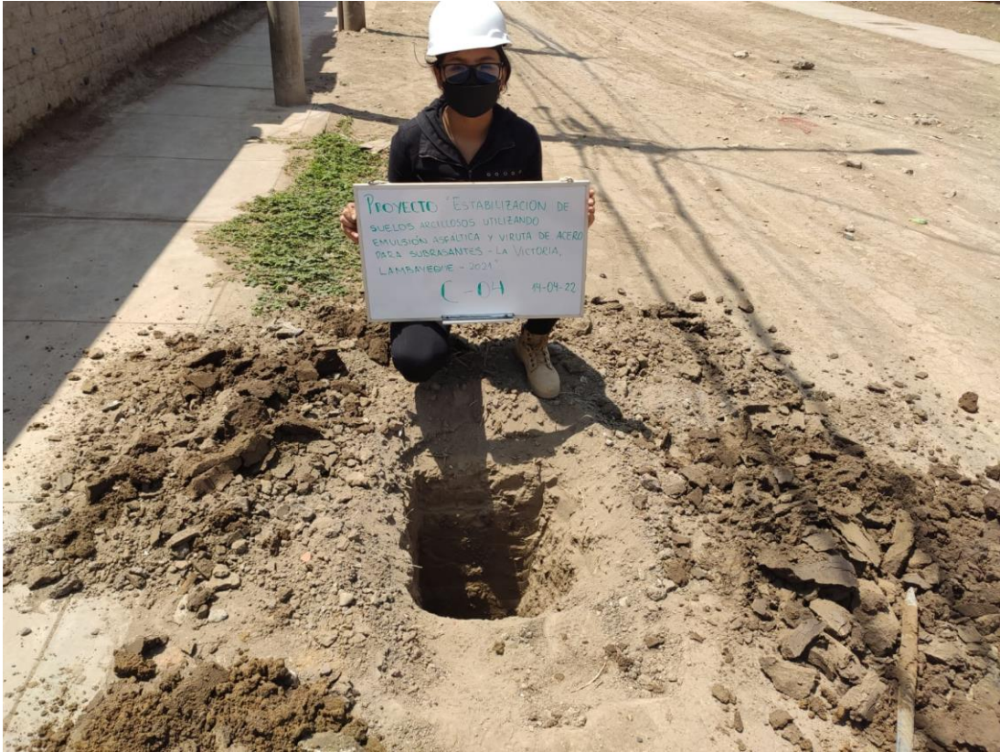
Fotografía VII: Excavación de calicata 04.
