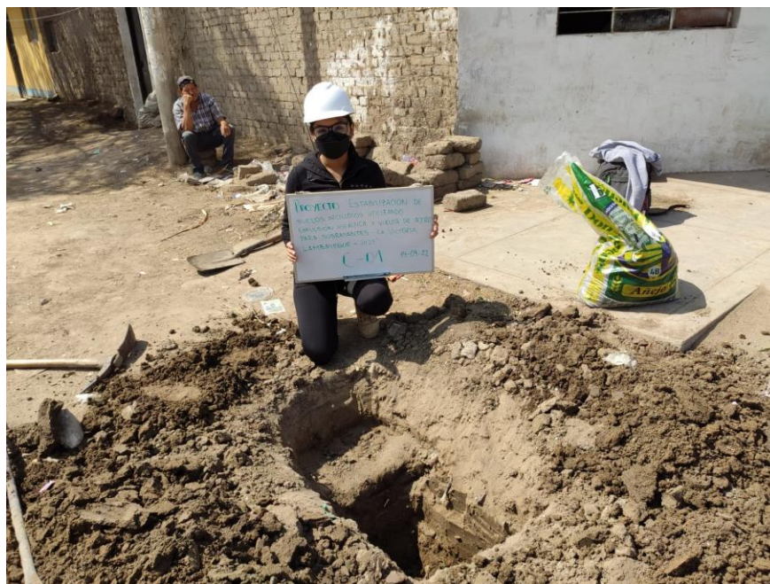
Figura 1: Excavación de calicatas Fuente: Elaboración propia
