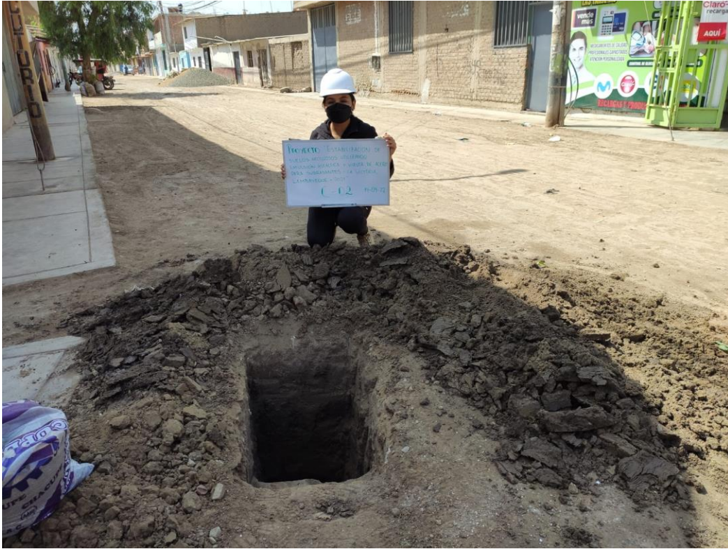
Fotografía III: Excavación de calicata 02.
