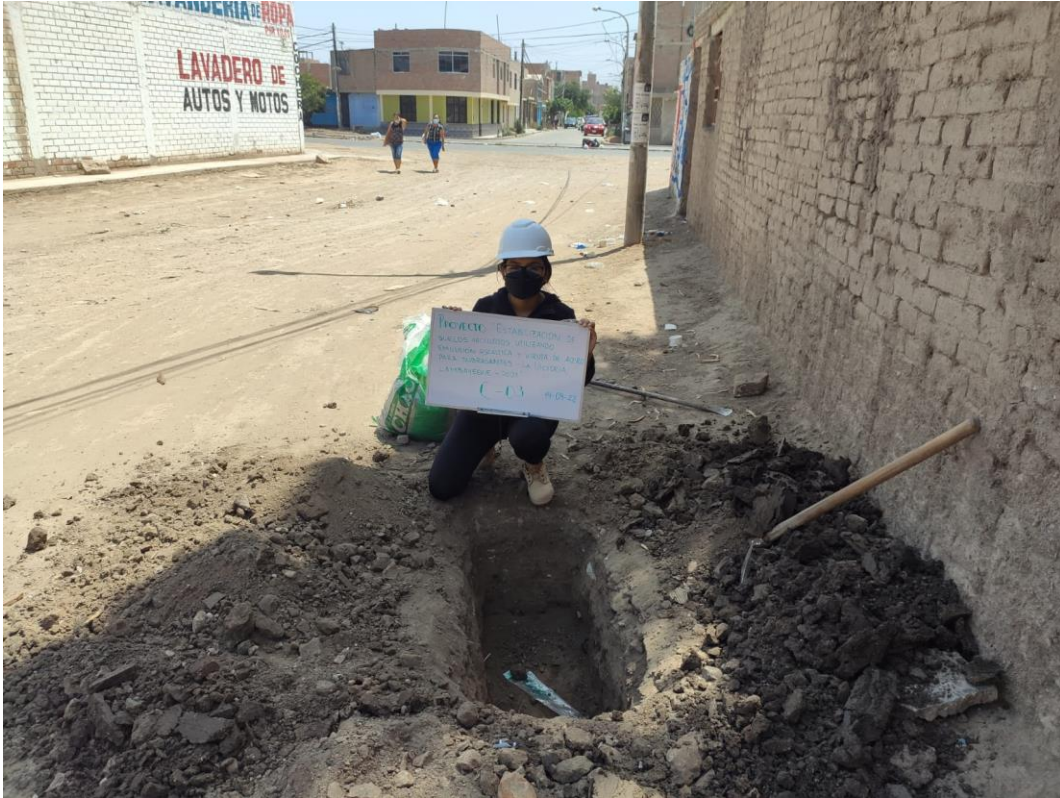
Fotografía V: Excavación de calicata 03.
