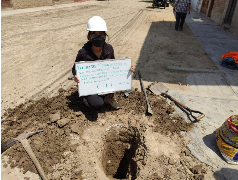
Fotografía XIII: Excavación de calicata 07.
