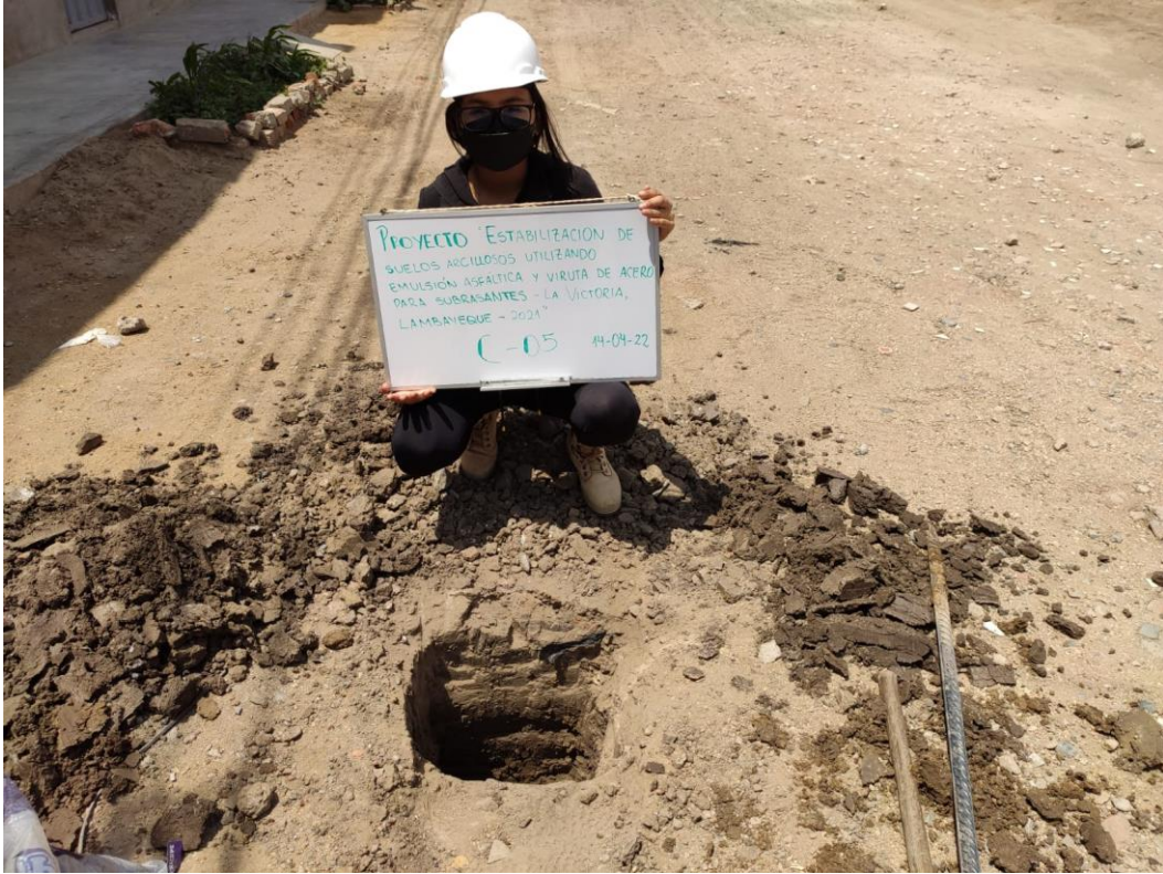
Fotografía IX: Excavación de calicata 05.
