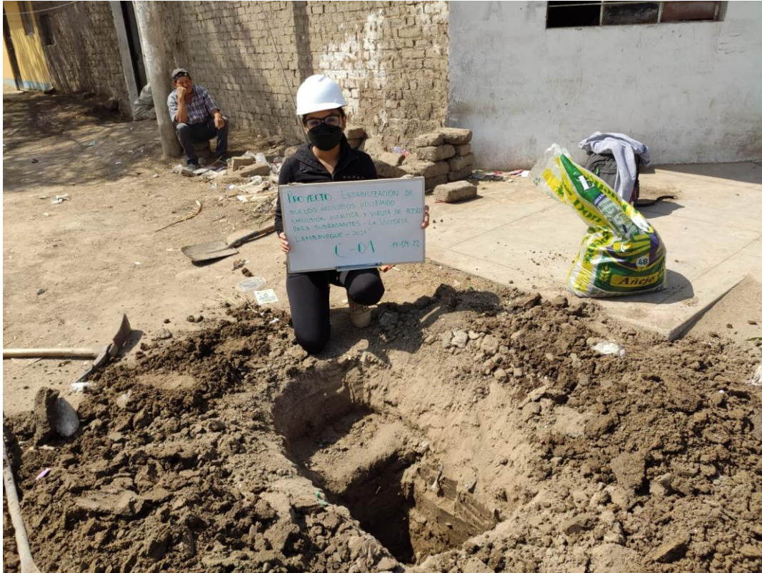
Fotografía I: Excavación de calicata 01
