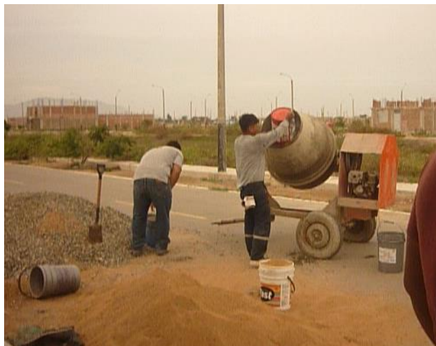
Imagen 16. Preparación del concreto.
