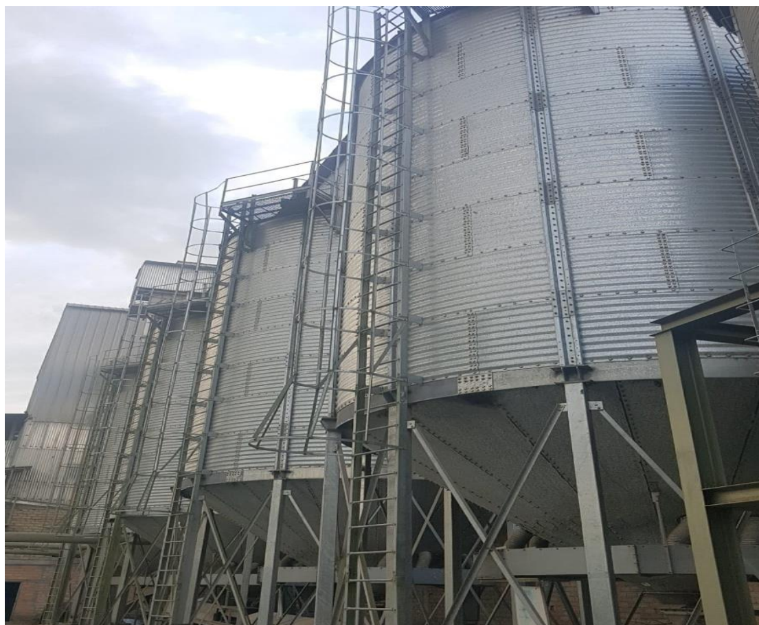
Figura 10. Silos almaceneros de arroz cáscara
