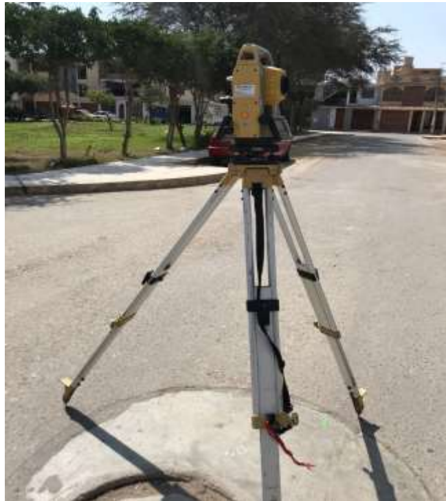
Figura 27. Colocación de estación total modelo TOPCON 105
