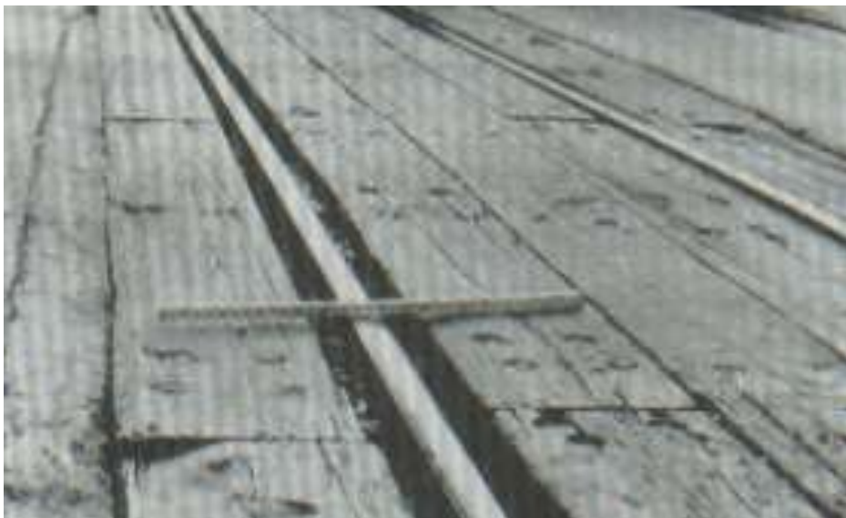
Figura 18 Cruce de vía férrea
