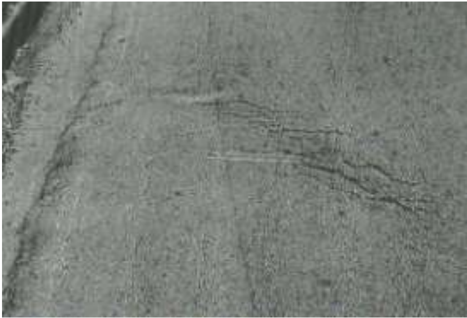
Figura 21 Grietas Parabólicas
