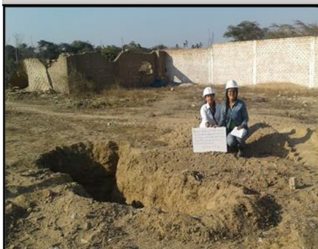
Calicata n° 2 – cisterna
