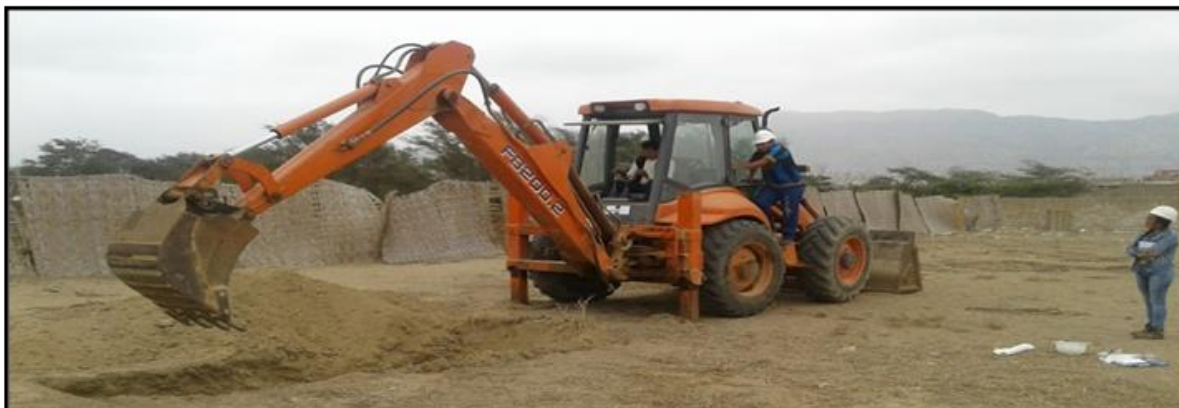
Calicata n° 1 – módulo gimnasio.
