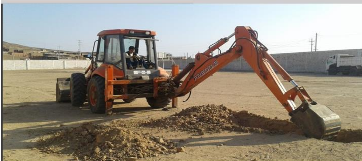
Calicata n° 6 – tribuna occidente
