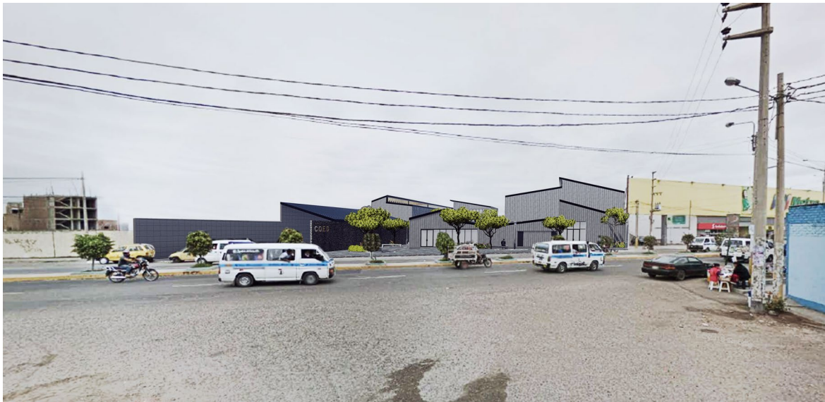
Figura 42. Vista Fachada Norte Av. Salaverry. Elaboración propia
