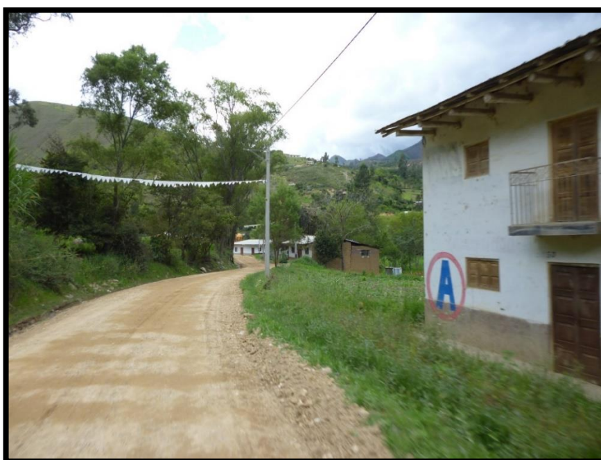
Fotografía 1.18. Tramo de Carretera Cutervo - Socota
