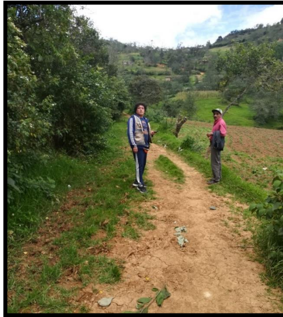
Figura 3. 33. Estado actual del tramo de la carretera
