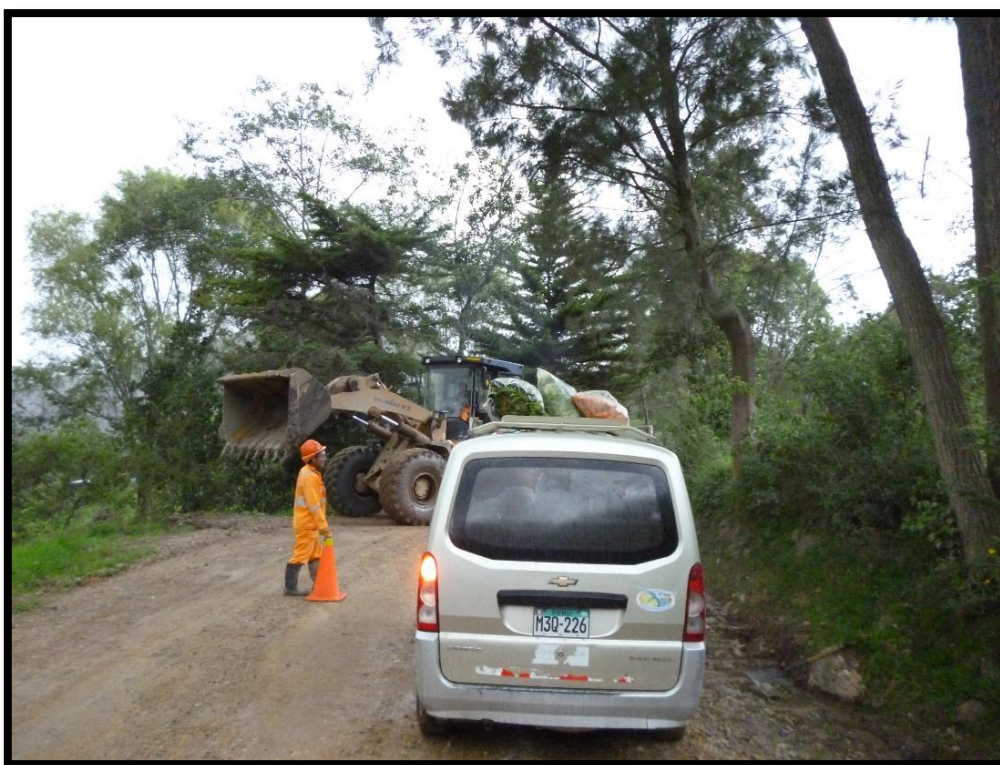
Fotografía 1.21. Trabajos en el tramo de la Carretera Cutervo - Cuyca
