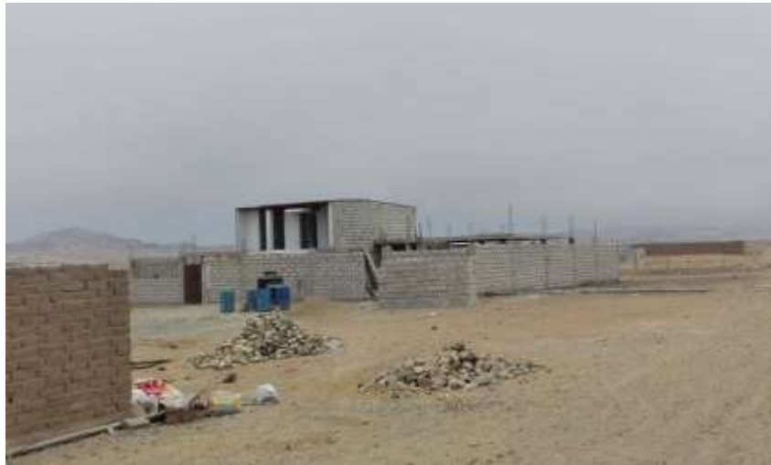
FOTOGRAFÍA N° 12: Casas en construcción en el Centro Poblado Cherrepe.
