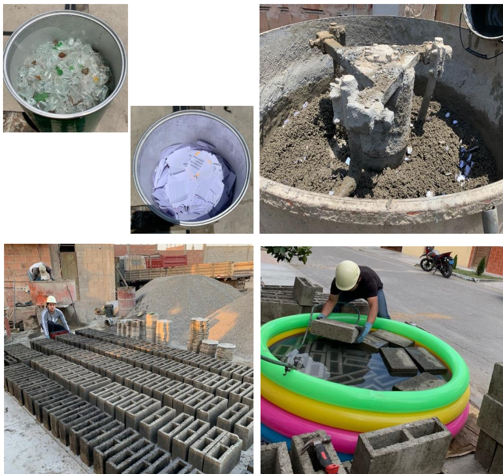
Figura 7. Fabricación y curado de Bloques de Concreto
