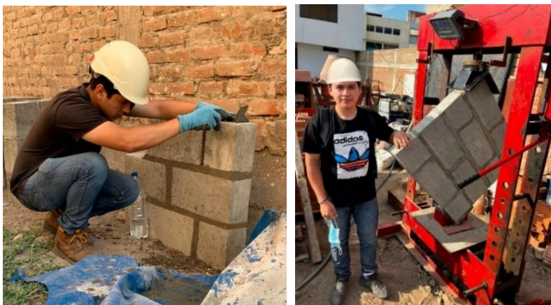
Figura 14. Ensayo de Resistencia a Compresión Diagonal
