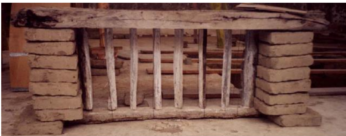
Ilustración 23 Carpintería de algarrobo canteado con hachuela, casi rollizo, empotrado en dintel con función de reja. Fuente: Historia de la construcción de Lambayeque.
