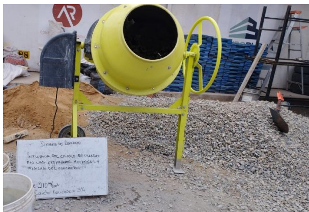
Figura N° 6 Elaboración de la mezcla de concreto- Fuente propia
