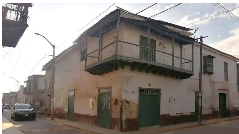
Fachada de la Casa Variás
