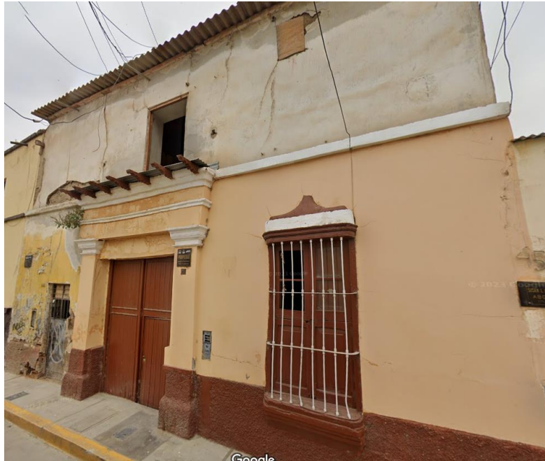
Fachada de la Casa Beneficencia I
