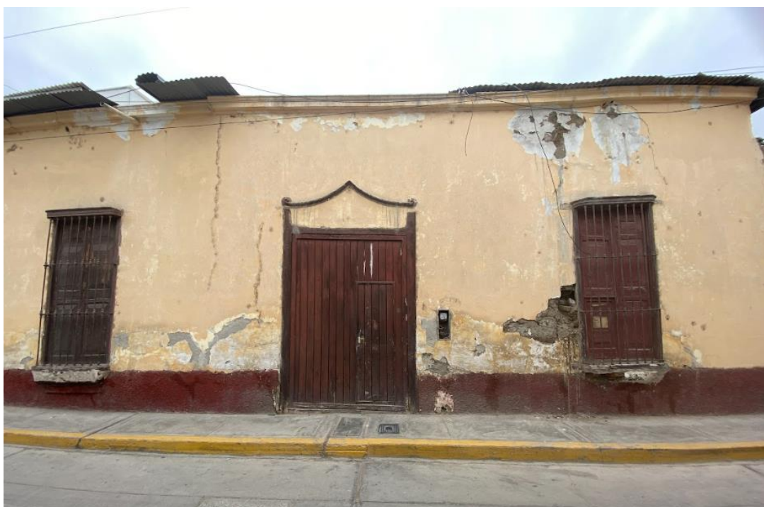
Fachada de la Casa Beneficencia II
