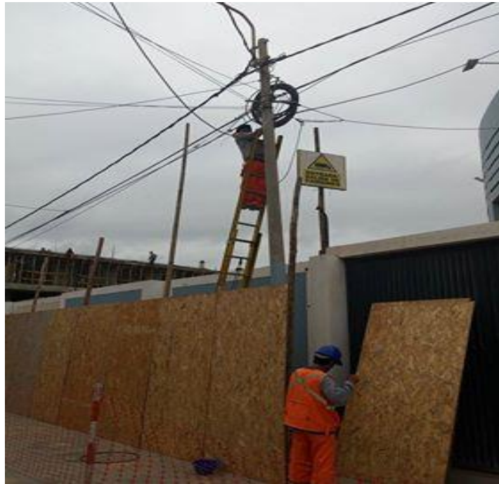
Figura 8. Trabajador en riesgo expuesto
