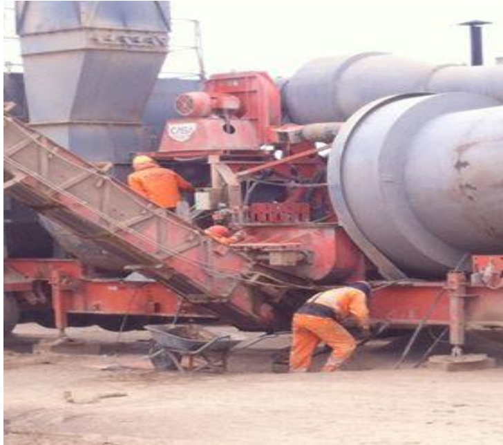
Figura 14. Trabajadores expuestos a peligros laborales
