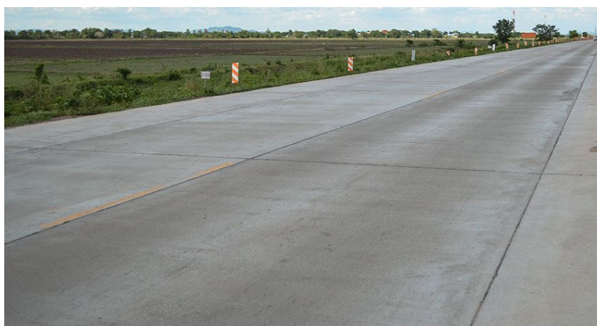
Figura N°06: Losa de Concreto en el Pavimento de concreto
