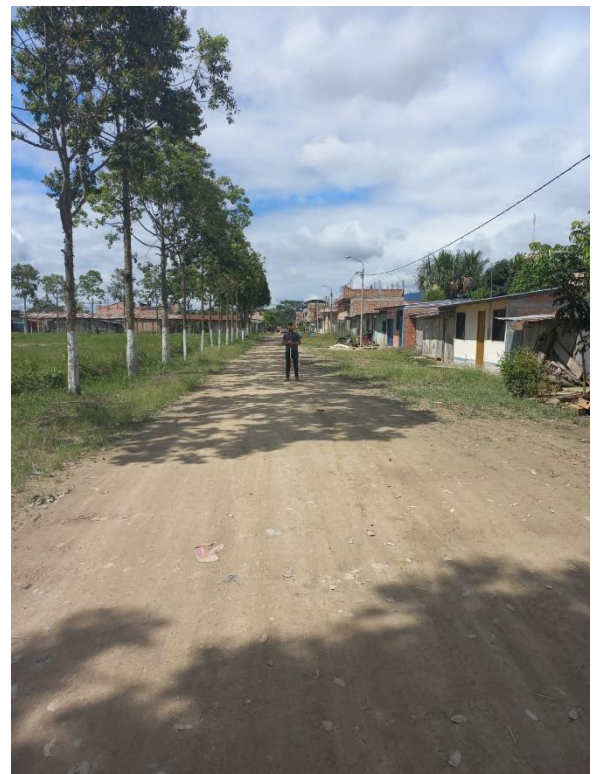
Toma de puntos eje central de calle
