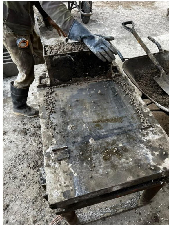
Figura 37. Vibración de la mezcla de concreto en el moldeado
