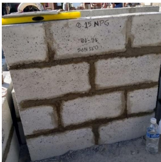
Figura 24. Murete de bloques de concreto
