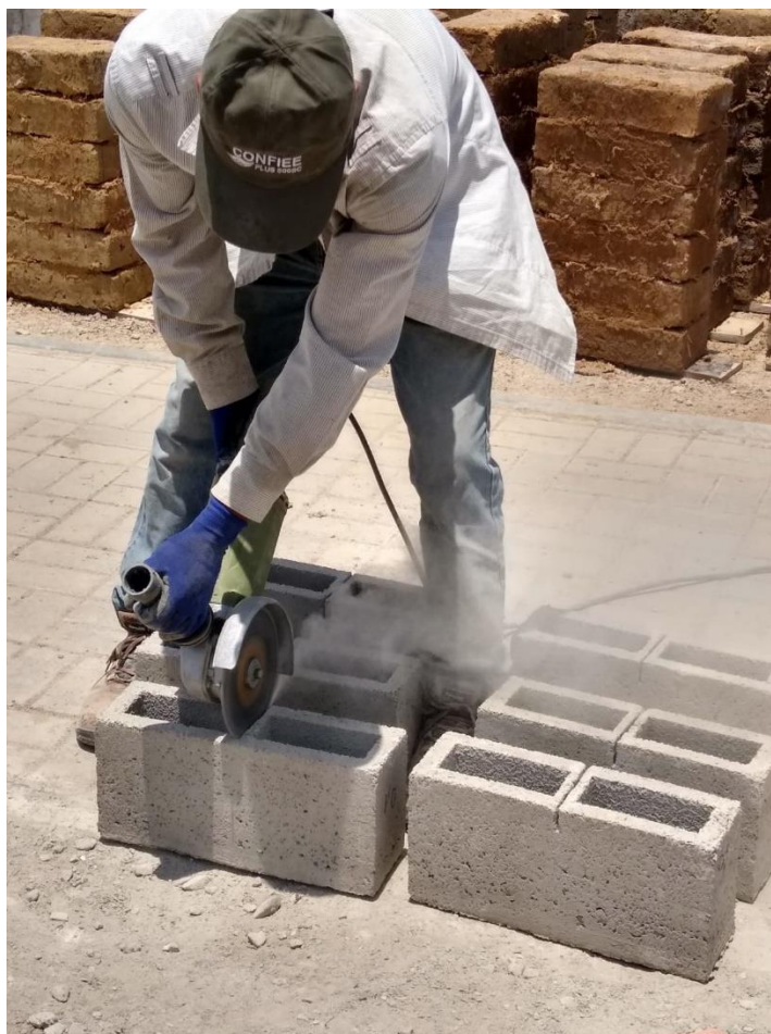
Figura 41. Bloques de concreto cortados con amoladora
