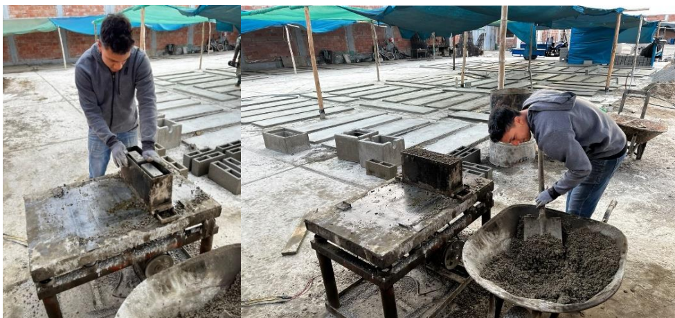
Figura 17. Moldeado de los bloques de concreto
