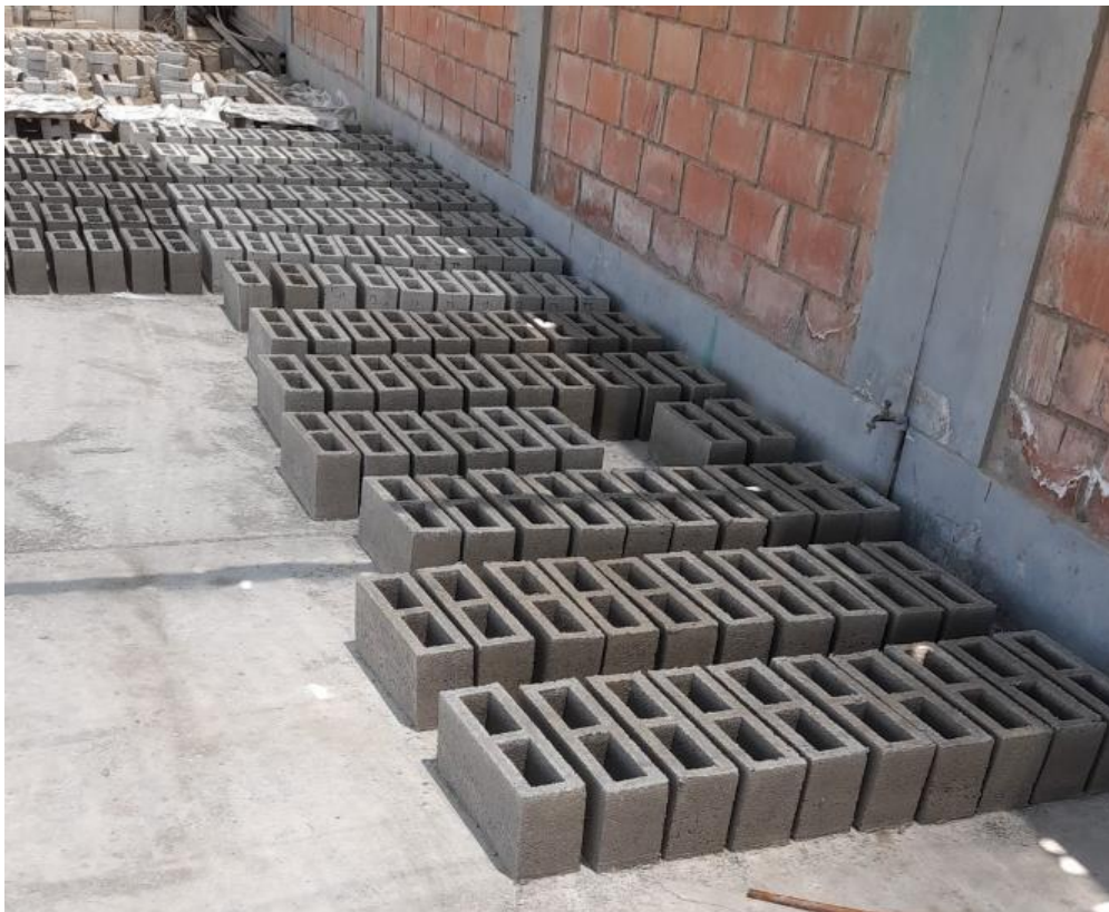
Figura 39. Almacenamiento de los Bloques de Concreto
