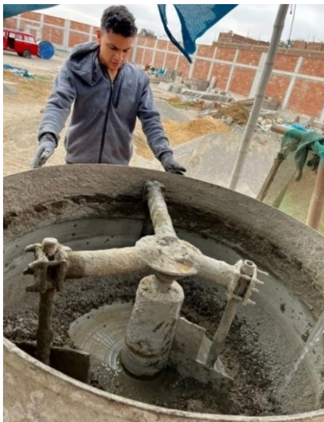
Figura 15. Mezclado de Concreto para Bloques
