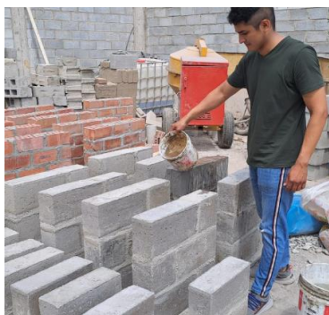
Figura 5 Muretes de Bloque de Concreto
