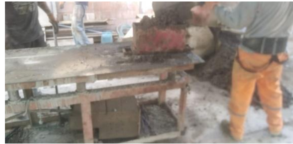
Figura 51 Vibrado del concreto en el molde
