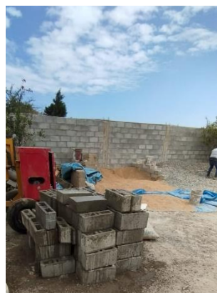
Figura 53 Bloques después de 1 día de secado.
