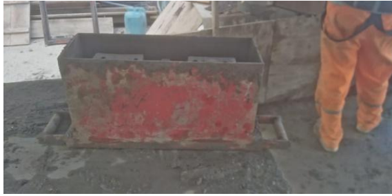
Figura 52 Moldeando la mezcla del molde de concreto
