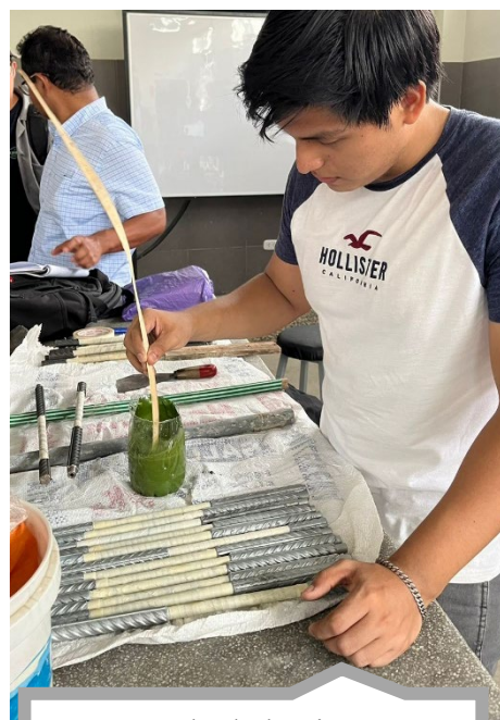
Mezcla de la pintura anticorrosiva con tñer
