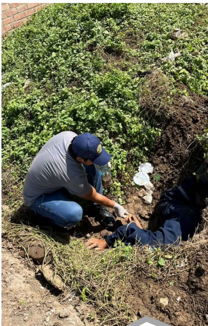
Calicata ubicada en Ciudad del Chofer
