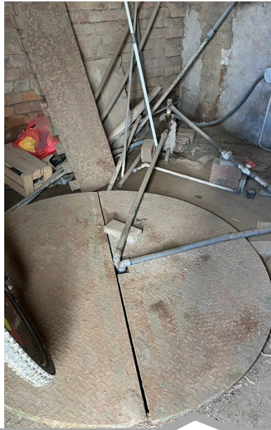
Pozo de terminal “La Gacela”
