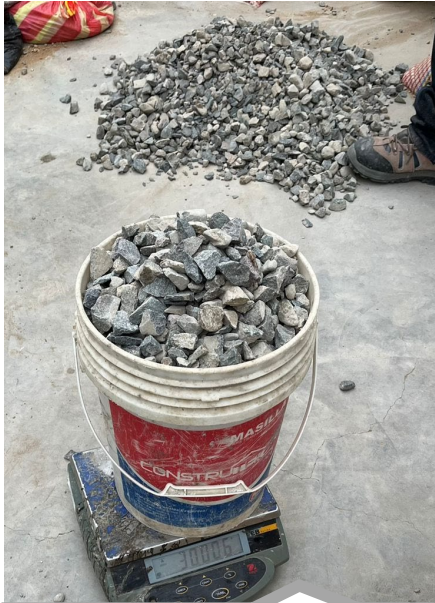
Pesaje de grava para la mezcla
