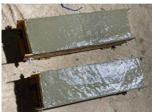
Ilustración 33: Moldeo de vigas
