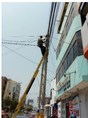
Figura 10. Instalación de fijador en poste de inicio de instalación
