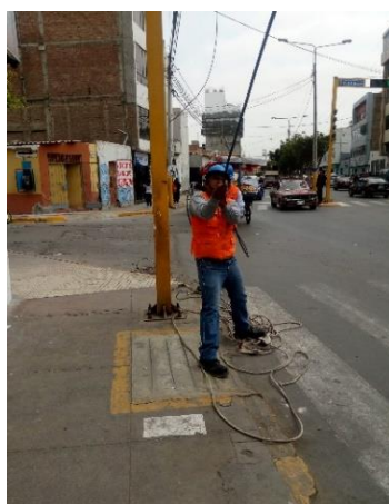
Figura 11. Tensado de cables (coaxial y mensajero) devanados
