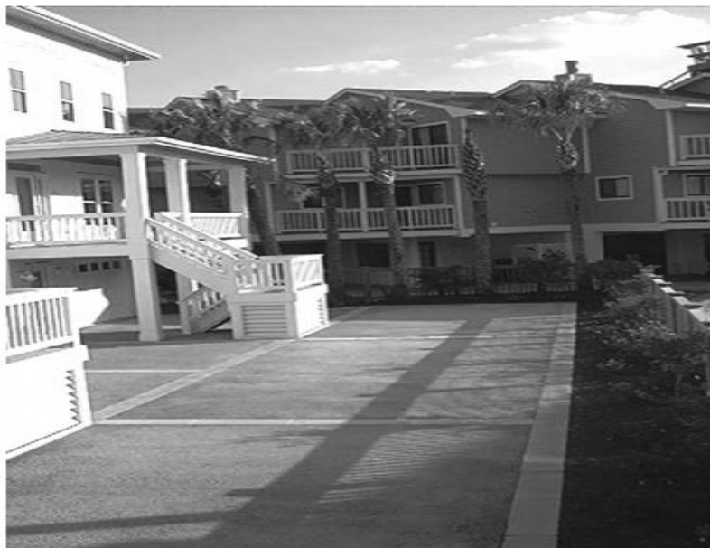
Figura 6: Pavimento de concreto permeable en zona urbana
