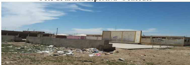
Figura N° 18: Foto de la losa deportiva “Foncodes”
