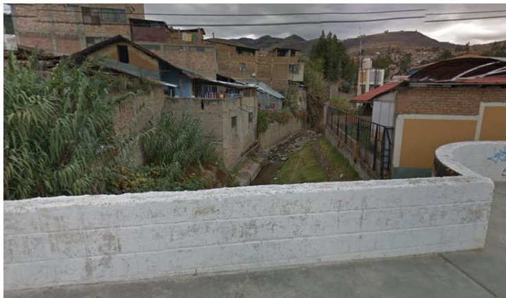
E. Tramo del Sector Urubamba Tramos del A y B fuente: Google Earth
