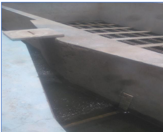
5. Segundo mezclado de sulfato de aluminio
