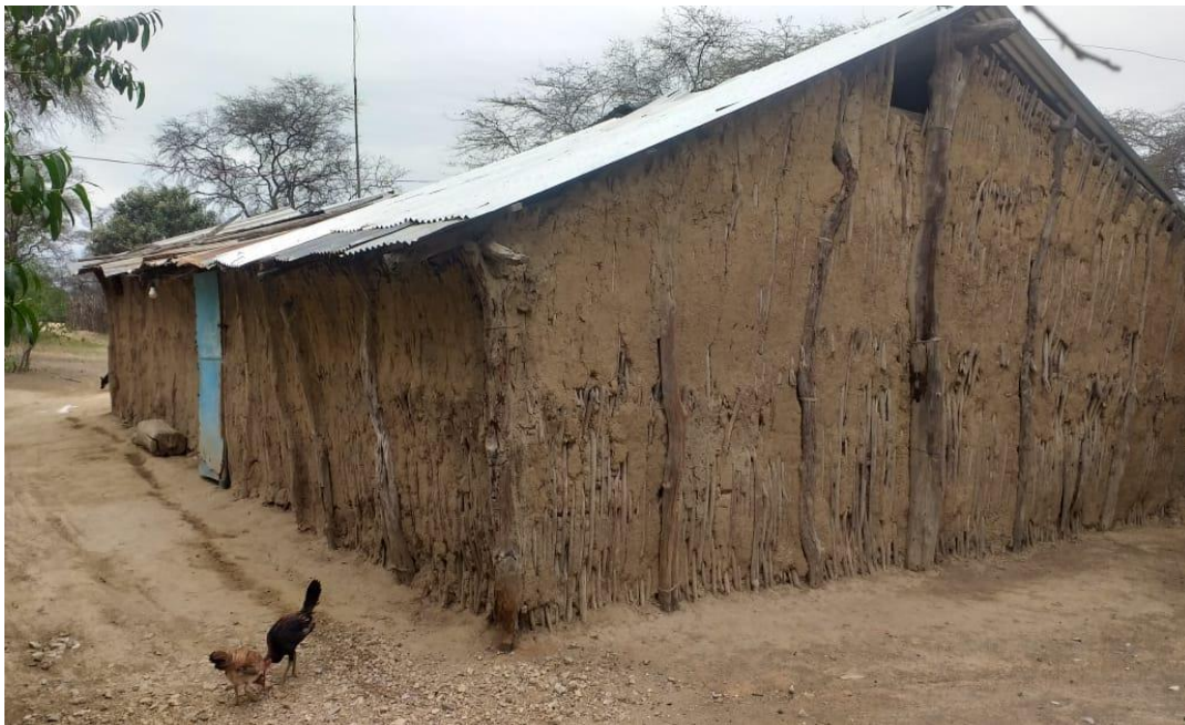
Figura 1-A: Vivienda construida de quincha con barro y cobertura de calamina
