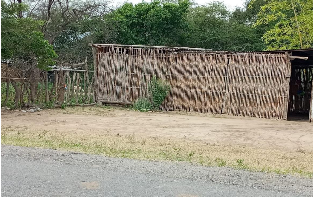
Figura 2-A: Vivienda construida de entramado de caña y cobertura de calamina
