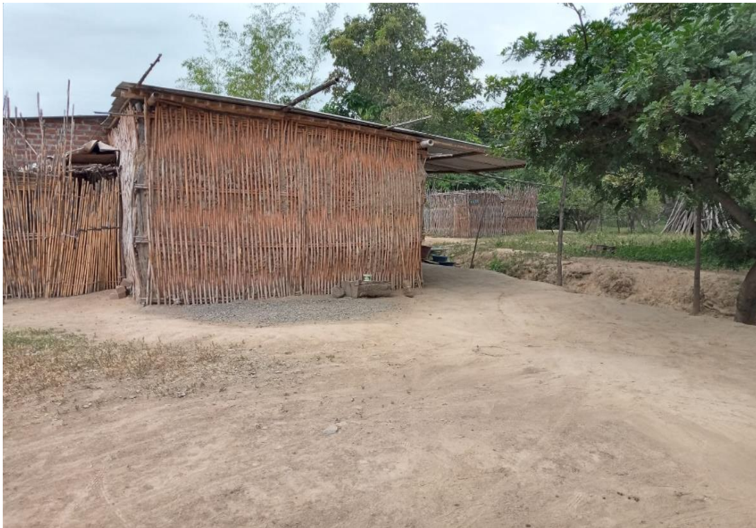
Figura 4-A: Vivienda construida de entramado de caña y cobertura de calamina
