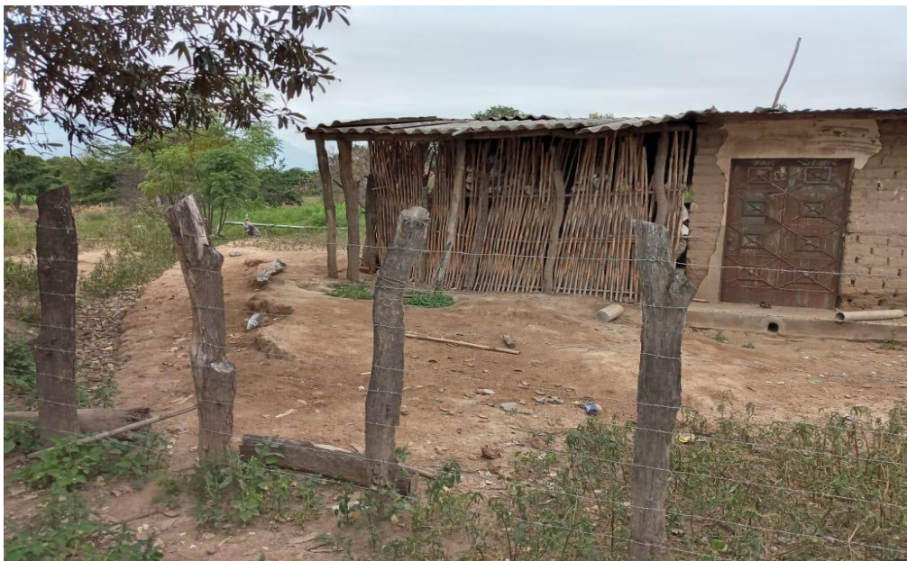
Figura 3-A: Vivienda construida de entramado de caña con cobertura de calamina, anexa a otra vivienda construida de adobe
