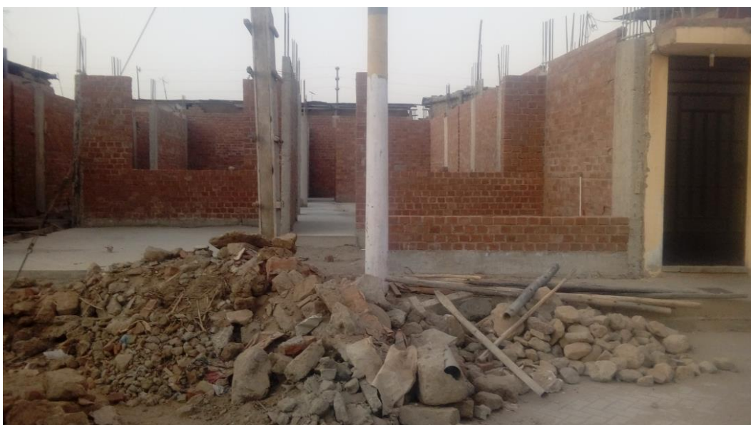
Fotografía 9. Almacenamiento temporal de los RCD afuera de la obra
