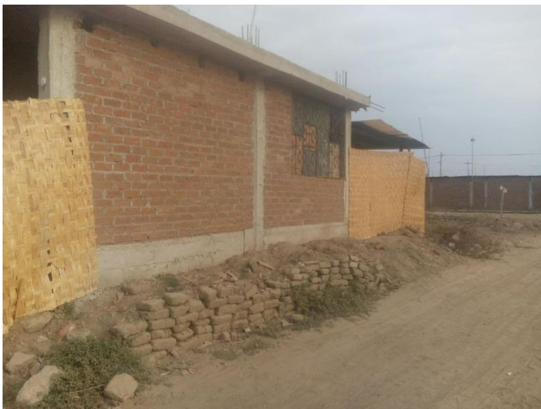
Fotografía 11. Fotografía de relleno de RCD para instalar una vivienda
