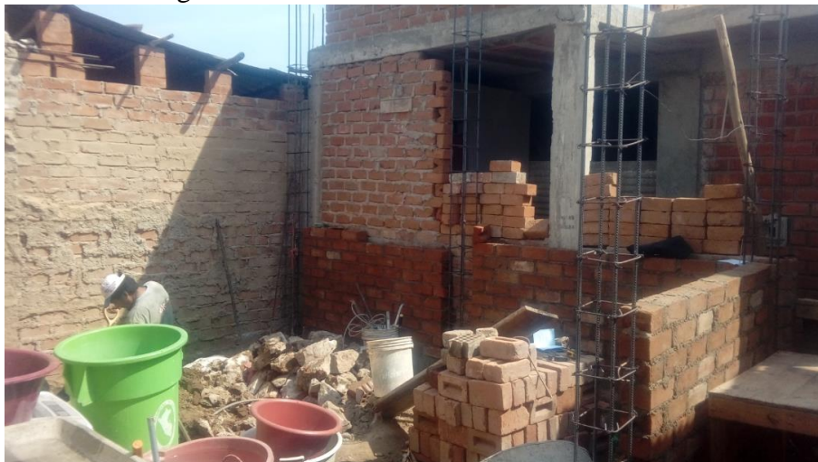
Fotografía 4. Obra de remodelación de la vivienda
