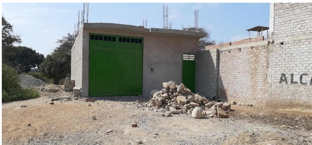
Fotografía 2. Infraestructura para almacén
