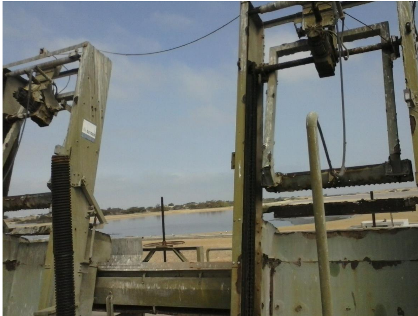
ANEXO 3. Cámara de rejas parte superior
