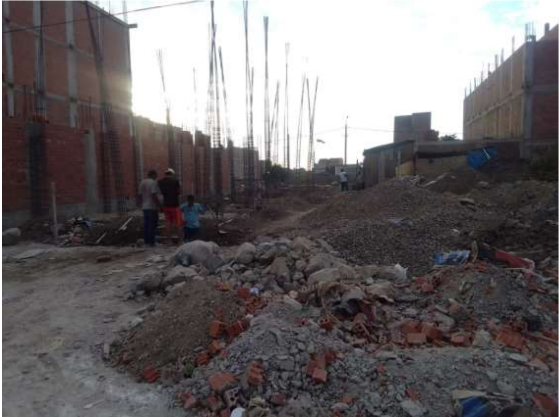
Figura 102 Fachada de la obra 03
