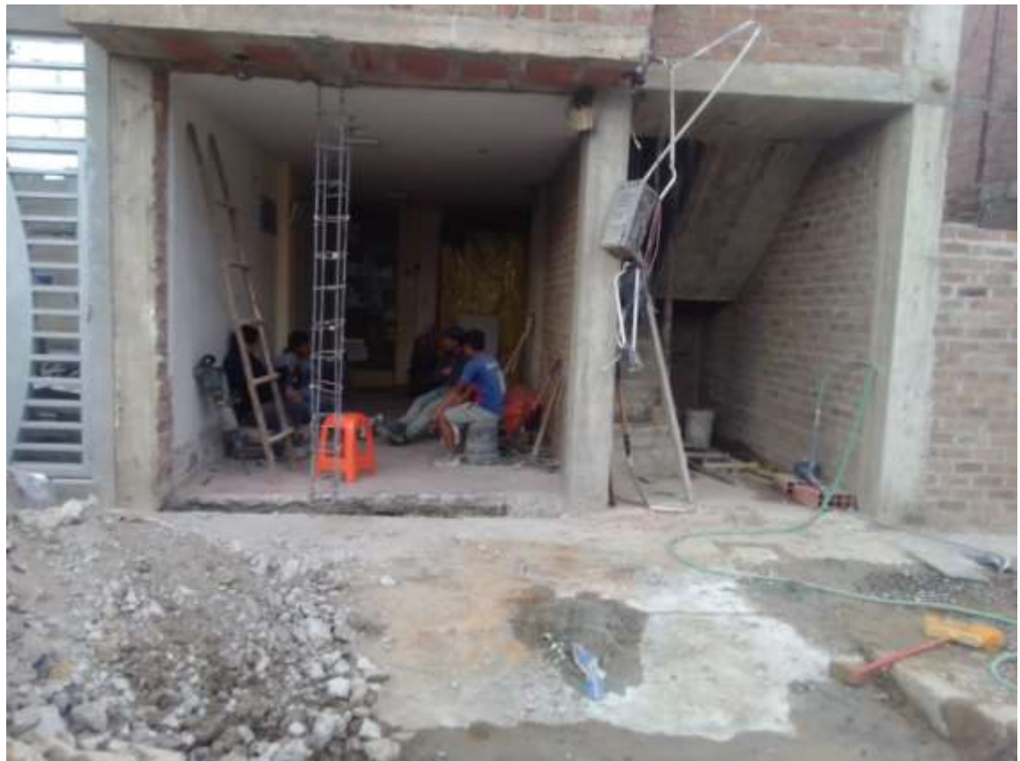
Figura 96 Fachada de la obra 02
