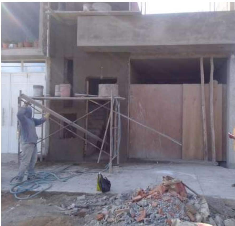
Figura 114 Fachada de la obra 04
