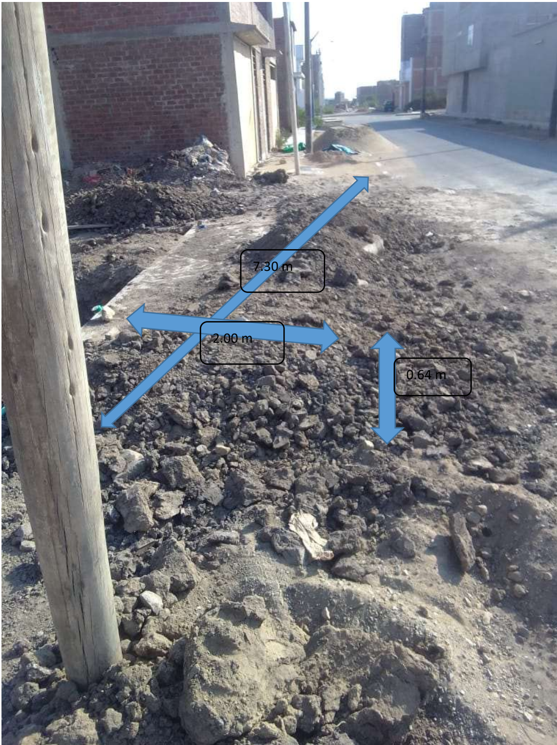
Figura 124 parte de los residuos de la obra 06
