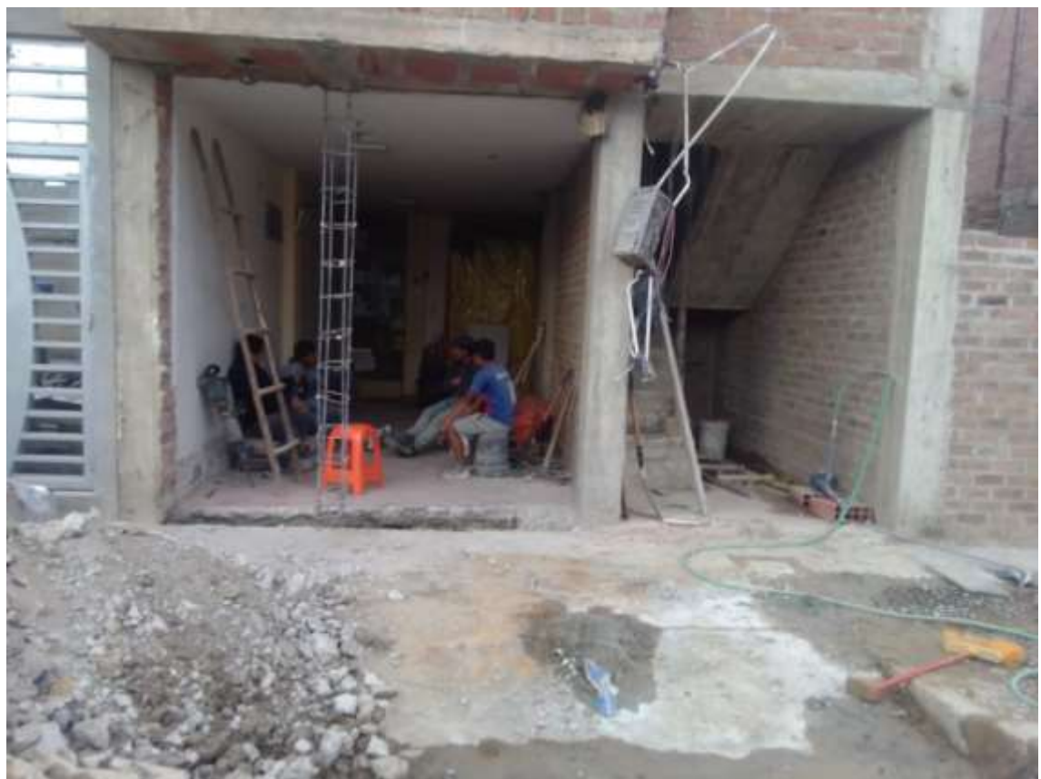
Figura 19 Fachada de la obra 02
