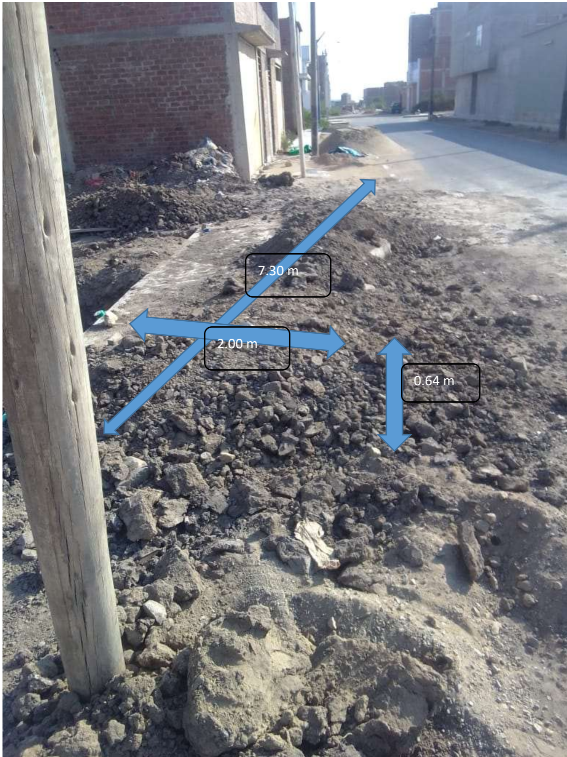
Figura 47 parte de los residuos de la obra 06
