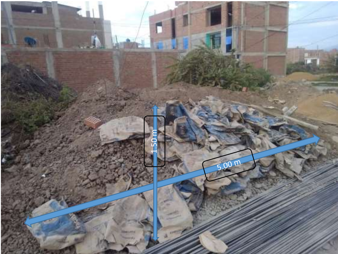
Figura 26 parte de los residuos de la obra 03
