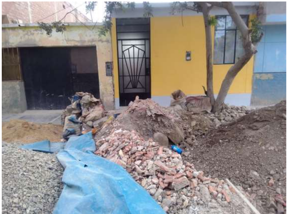
Figura 11 Fachada de la Obra 01
