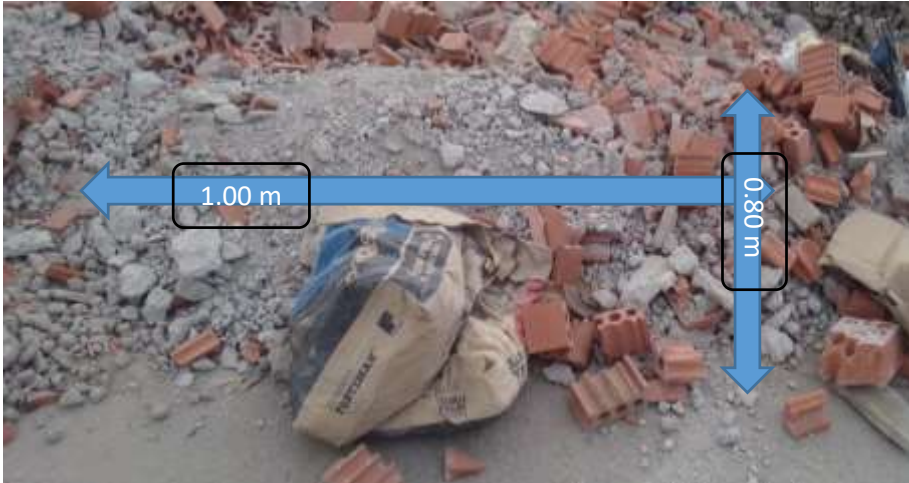
Figura 34 Residuos encontrados en la obra 03
