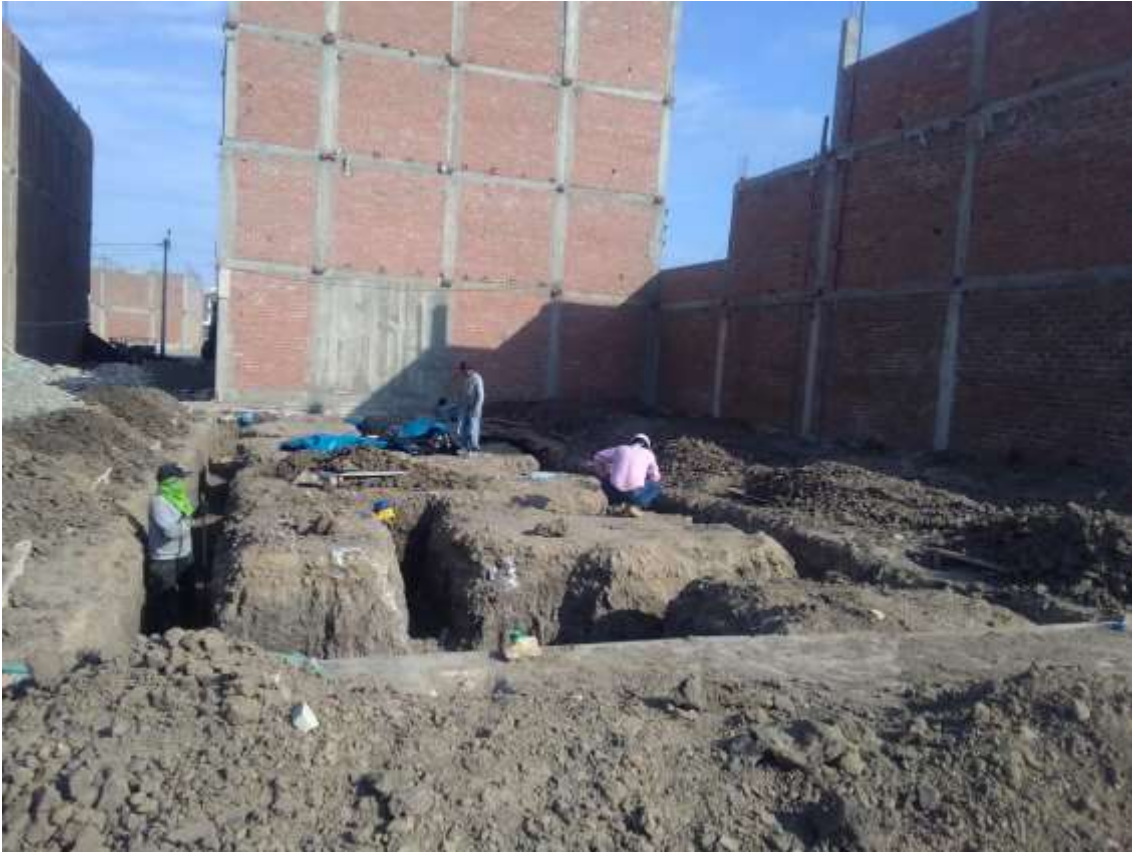
Figura 123 fachada de la obra 06
