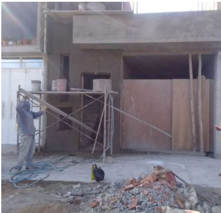
Figura 37 Fachada de la obra 04
