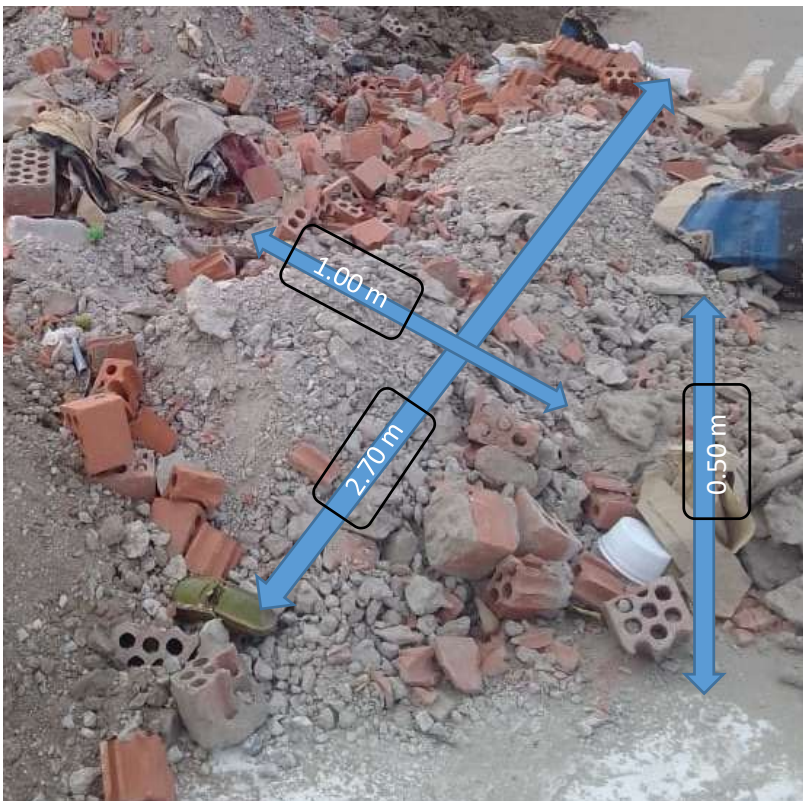
Figura 33 Residuos encontrados en la obra 03
