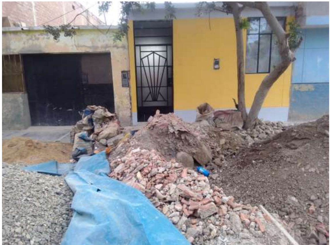
Figura 88 Fachada de la Obra 01
