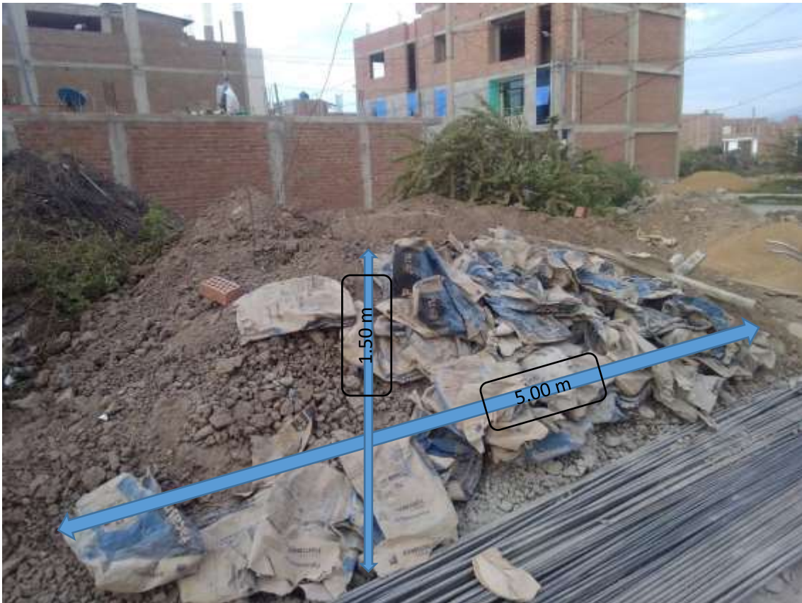
Figura 103 parte de los residuos de la obra 03
