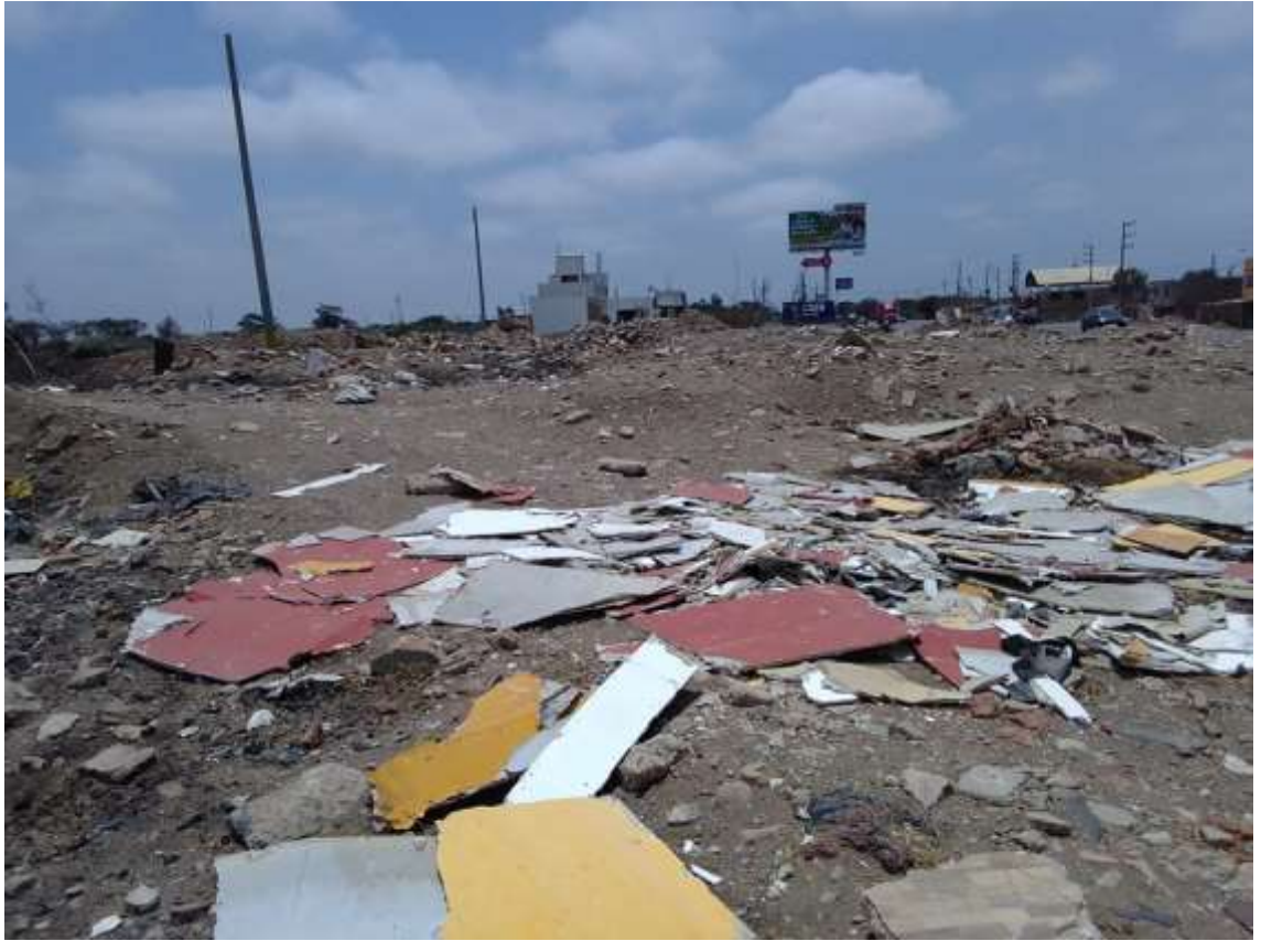
Figura 85 Estado de los residuos kilómetro 774 de la carretera panamericana norte
