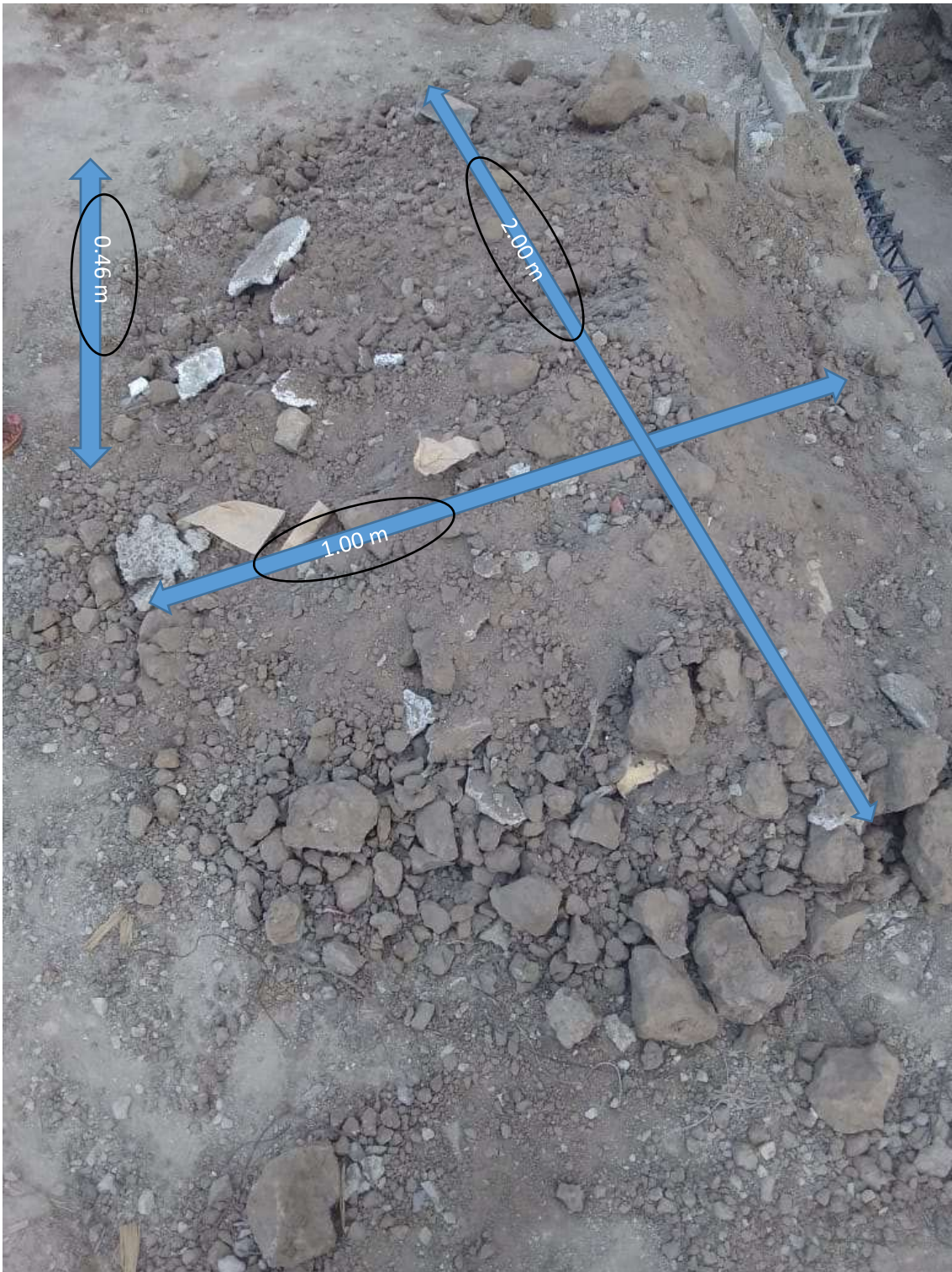
Figura 28 Desmote encontrado en la obra 03
