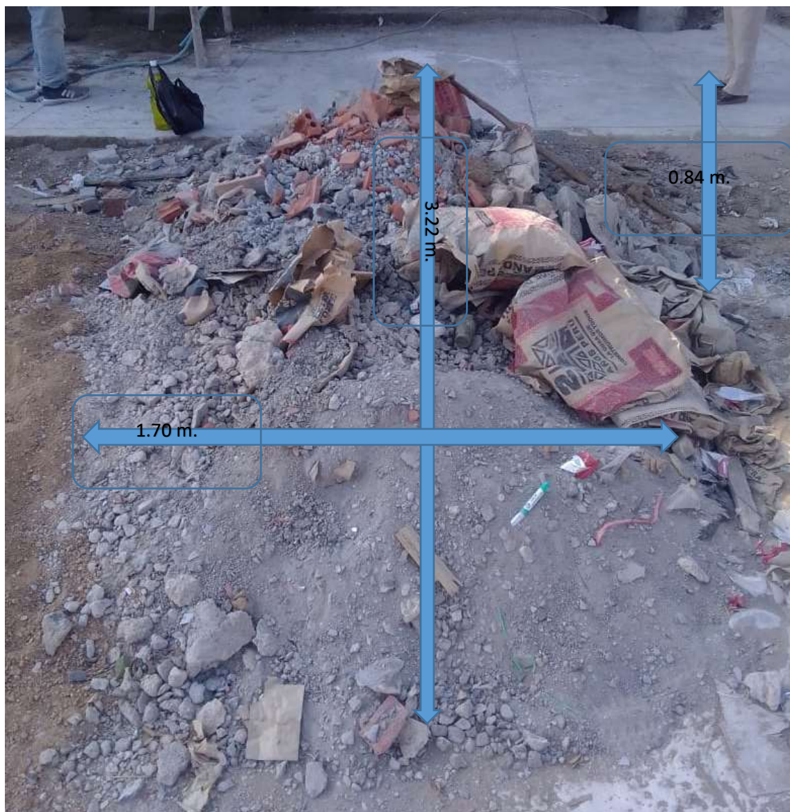
Figura 115 Ubicación de los residuos en la obra 04
