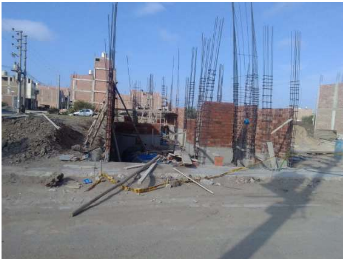
Figura 118 fachada de la obra 05
