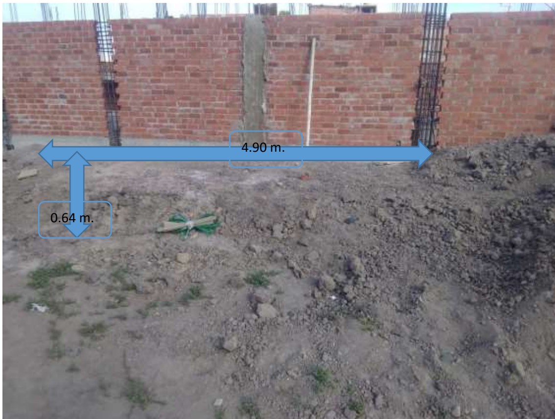
Figura 120 desmonte encontrado en la obra 05
