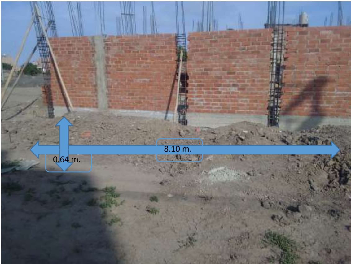
Figura 121 desmonte encontrado en la obra 05
