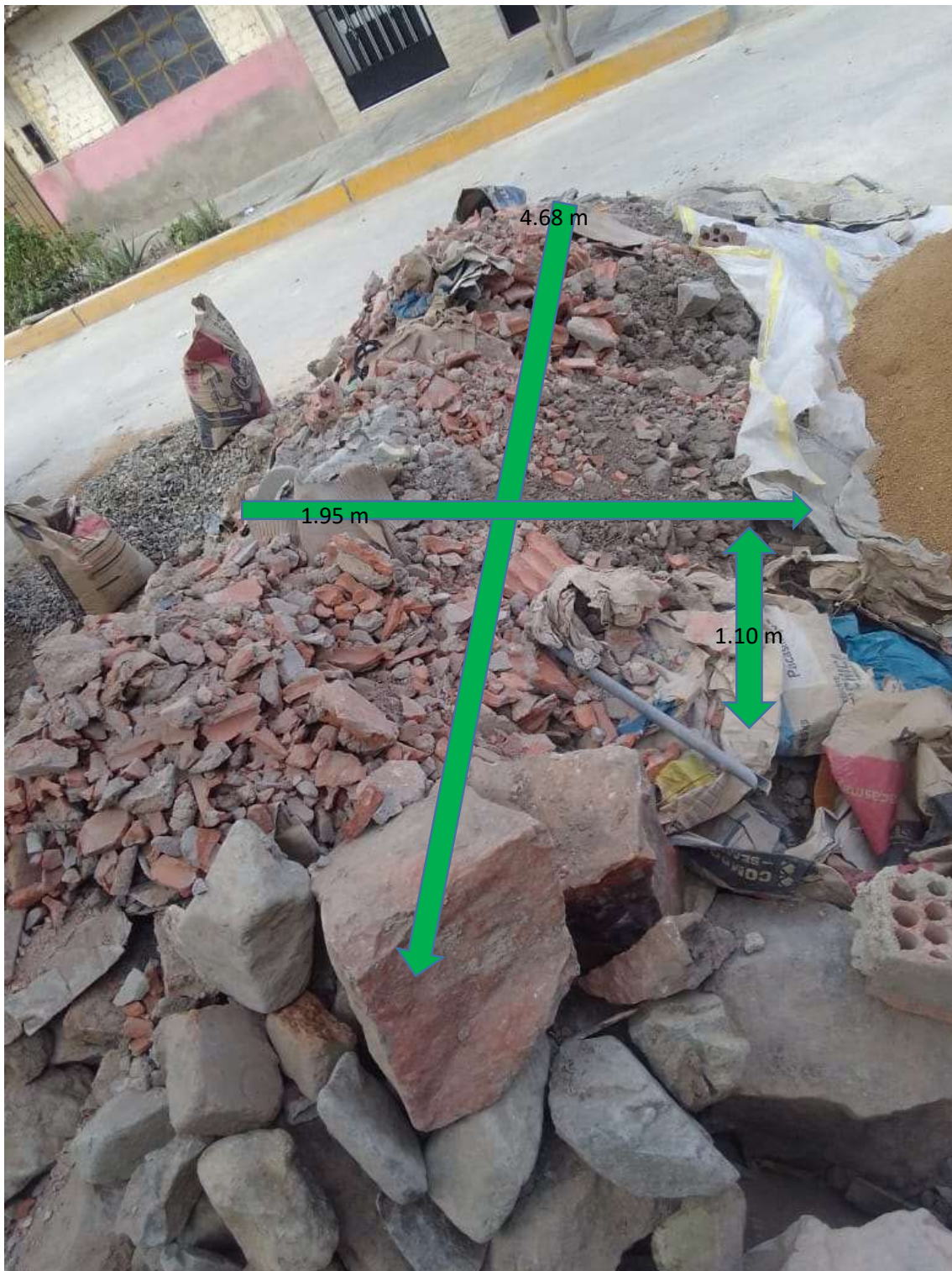
Figura 89 Ubicación de los RCD en la obra 01
