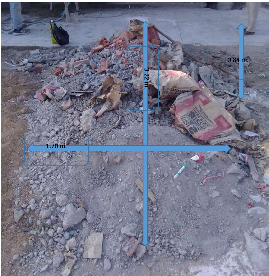
Figura 38 Ubicación de los residuos en la obra 04
