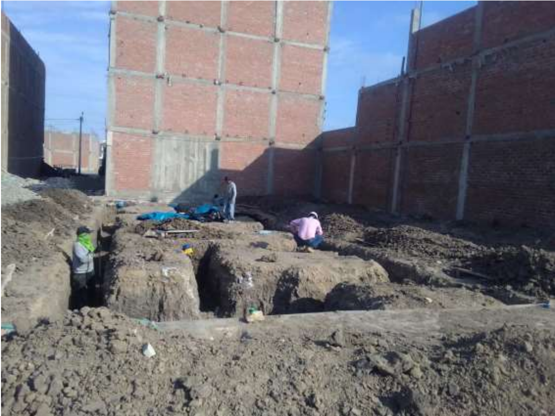
Figura 46 fachada de la obra 06
