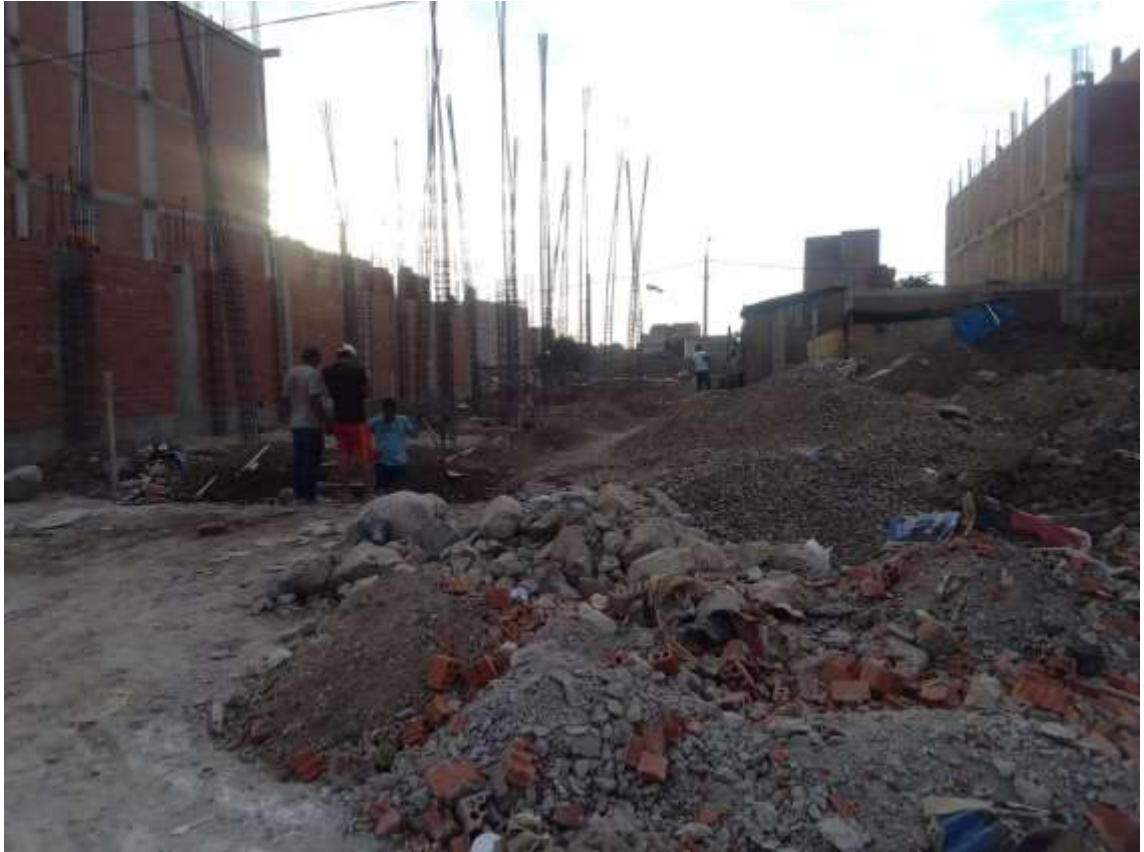
Figura 25 Fachada de la obra 03
