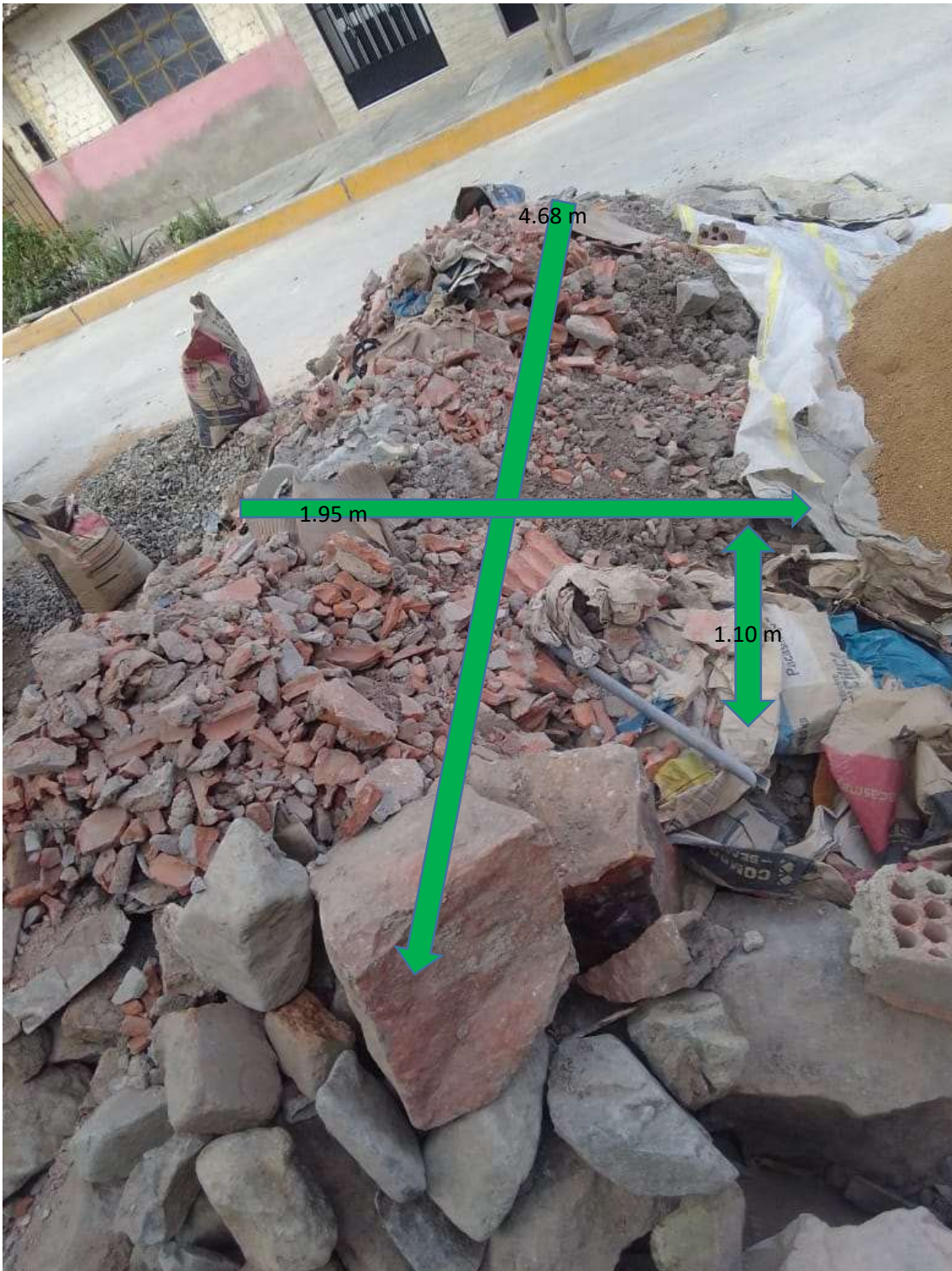
Figura 12 Ubicación de los RCD en la obra 01
