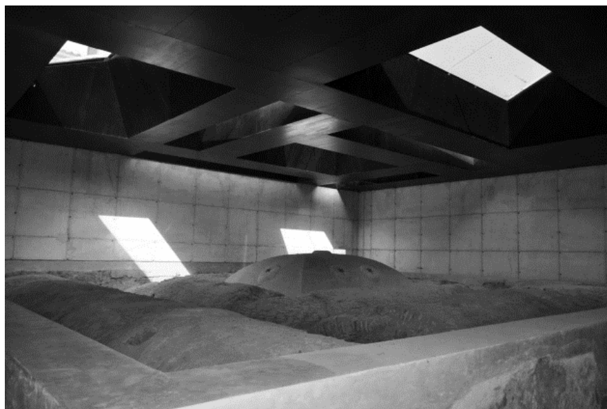
Imagen 6: Superposición de cubierta histórica y contemporánea de los baños de Baza- Francisco Ibañez Fuente: Julia García.
