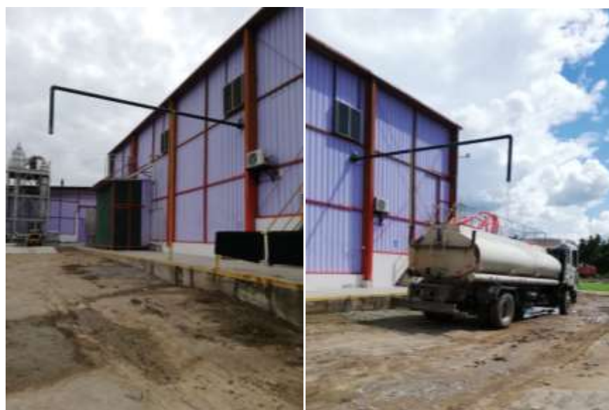
Figura 49. Tanque de camión cisterna en Quicornac SAC
