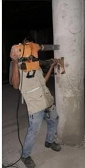
Fotografía: Extracción de diamantina I
