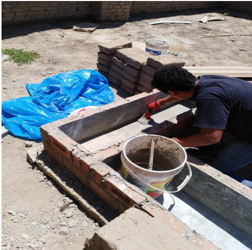
Fig. 95. Impermeabilización del Canal
