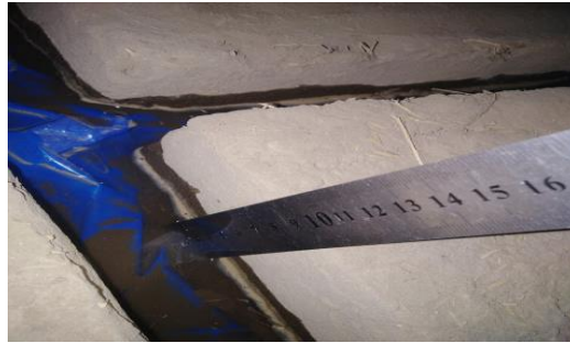
Fig. 80. Nivel de agua 2.5 cm para el ensayo de eflorescencia.
