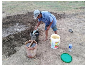
Fig. 16 Mezclado del agua usada para la elaboración de las unidades de adobe con San Pedro 3%
