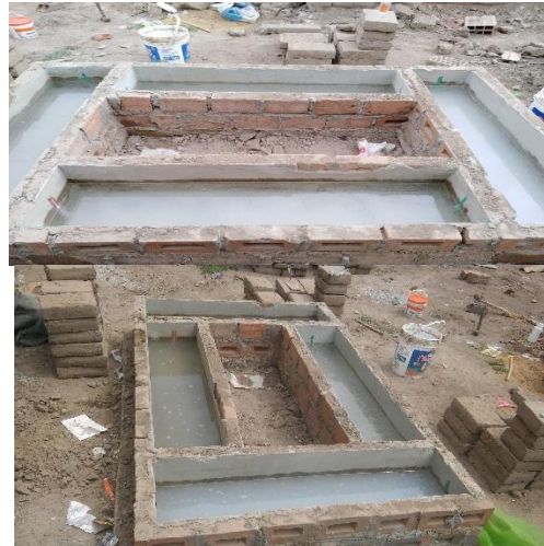
Fig. 96. Prueba Hidráulica del Canal
