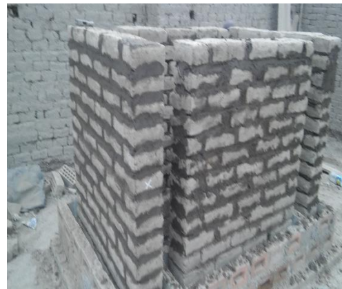
Fig. 98. Muros construidos con porcentaje de estabilizante de 3% y 6%
