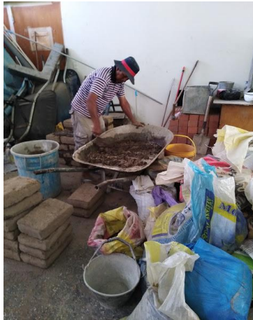
Fig. 79. Fabricación de los muretes para ensayo de “Resistencia a la compresión en diagonal de muretes”.
