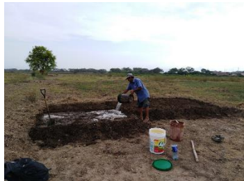
Fig. 17 Colocación del agua mezclada con San Pedro 3% a la tierra usada para la fabricación de las unidades de adobe
