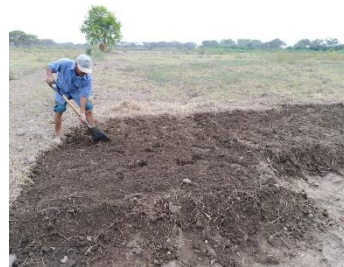
Fig. 14 Separación del suelo a trabajar para su respectivo remojo un día antes de la elaboración de las unidades de adobe
