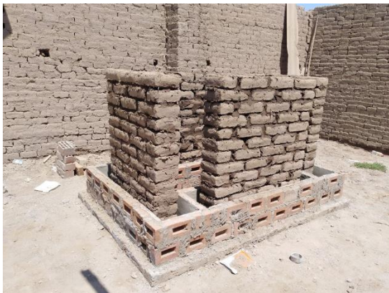
Fig. 97. Muros construidos con porcentaje de estabilizante de 9% y 12%
