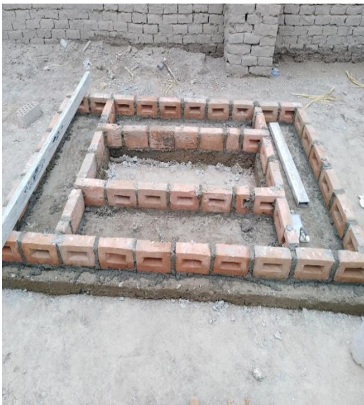
Fig. 93. Construcción del canal
