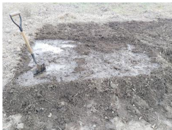
Fig. 15 Remojo de la tierra para su posterior mezclado con agua estabilizada
