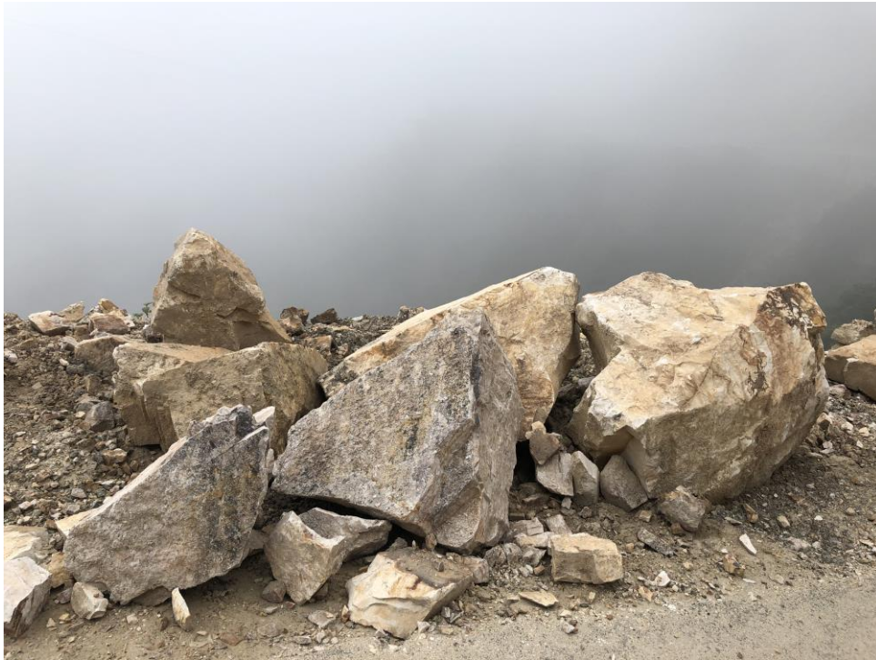
IMÁGEN N°3.7: Desprendimiento de rocas en el tramo del proyecto.
