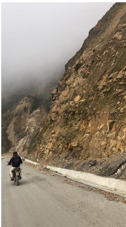
FIGURA N°4.2: Vista general del talud de corte del tramo evaluado.
