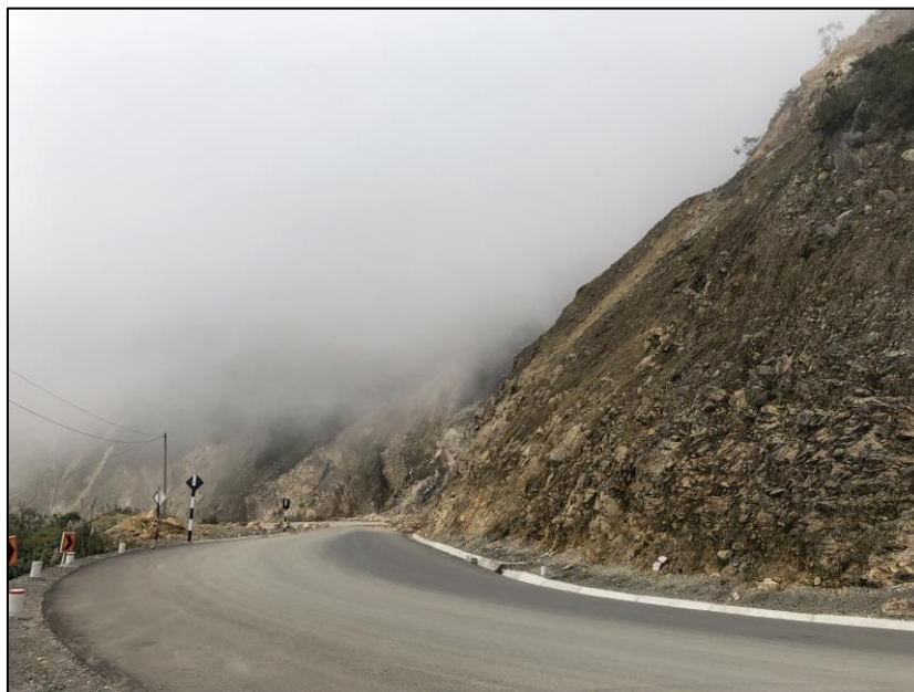
Figura 17. Vista longitudinal del tramo Km 46+300 – Km 46+350.
