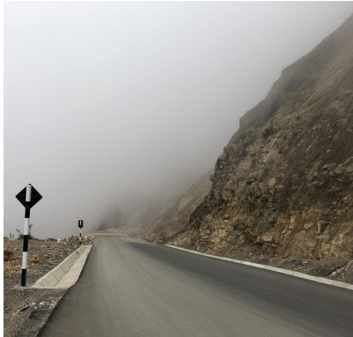
IMÁGEN N°3.3: Vista del tramo del proyecto.
