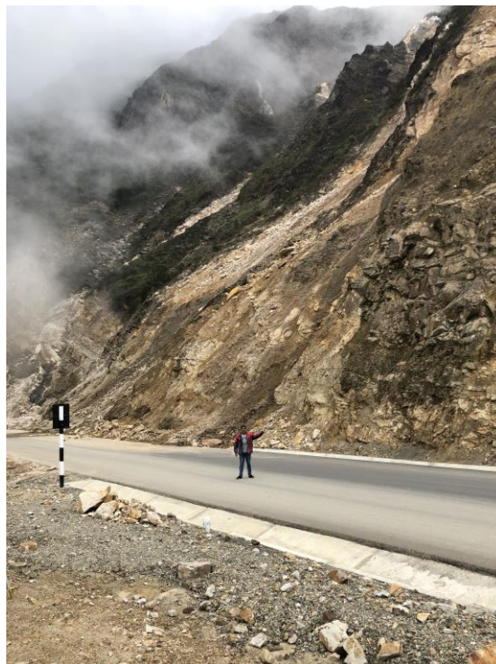
IMÁGEN N°3.4: Vista del tramo y talud del proyecto.
