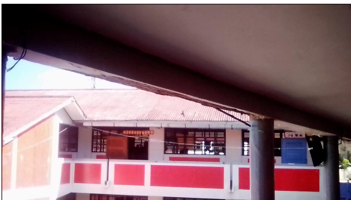
FOTOGRAFÍA N°4.12: VIGAS HECHAS DE QUINCHA
