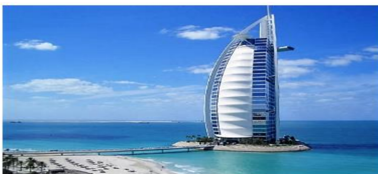
Figura 6 Edificación Burj Al-Arab
