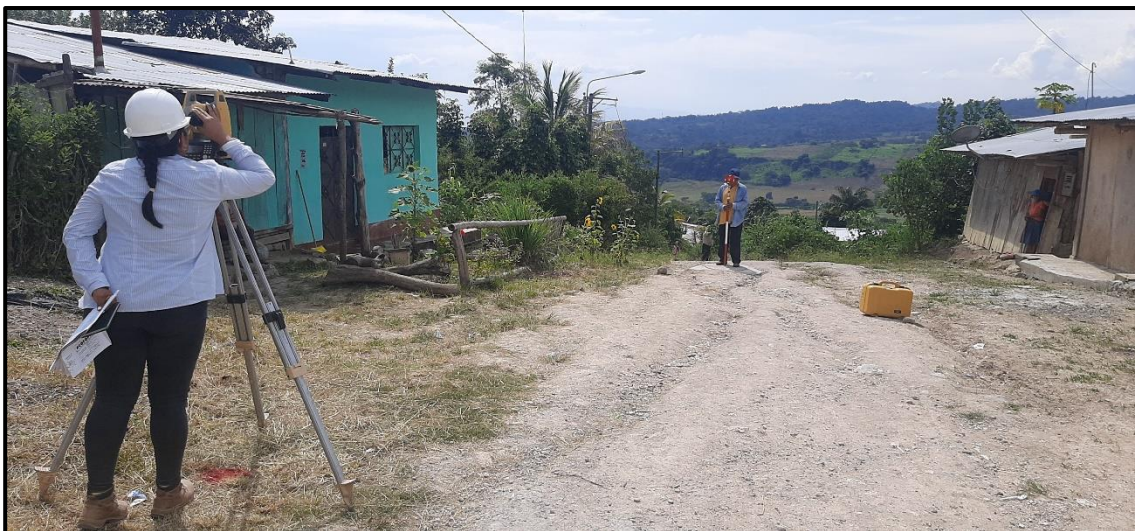
IMAGEN N°02. 19: TOMA DE PUNTOS CON ESTACIÓN TOTAL
