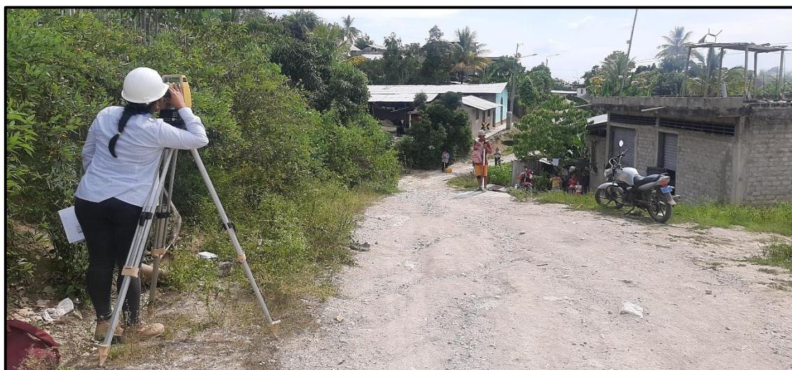
IMAGEN N°02. 20: TOMA DE PUNTOS CON ESTACIÓN TOTAL – JR. JAEN
