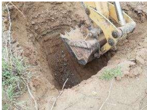
Fotografía 7. Excavación de calicata 5
