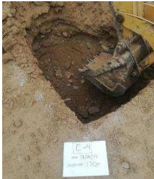
Fotografía 6. Excavación de calicata 4
