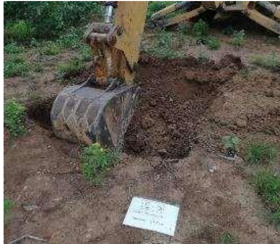
Fotografía 5. Excavación de Calicata 3
