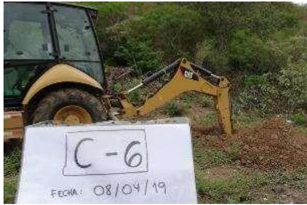
Fotografía 8. Excavación de calicata 6
