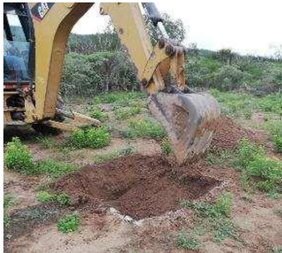
Fotografía 4. Excavación de Calicata 2
