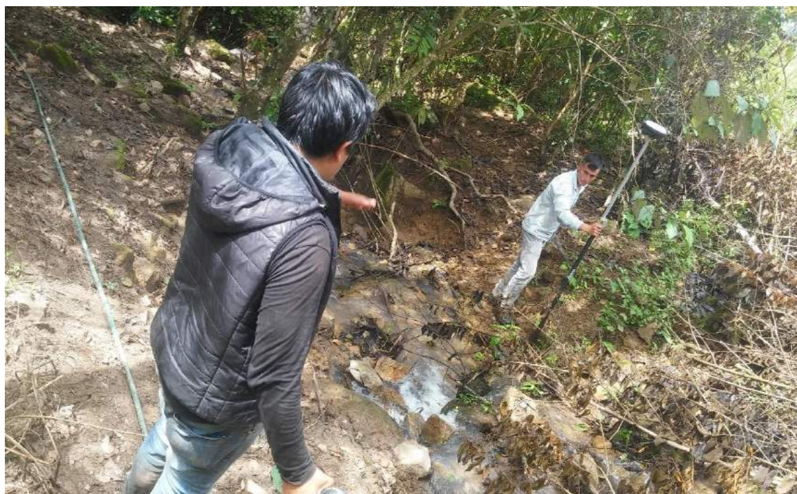
FIGURA N° 73: levantamiento de pases de Agua
