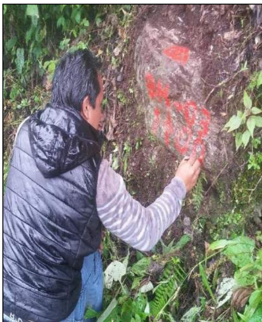
FIGURA N° 56 Ubicación de BM-03 y BM-04 en roca con su respectiva descripción
