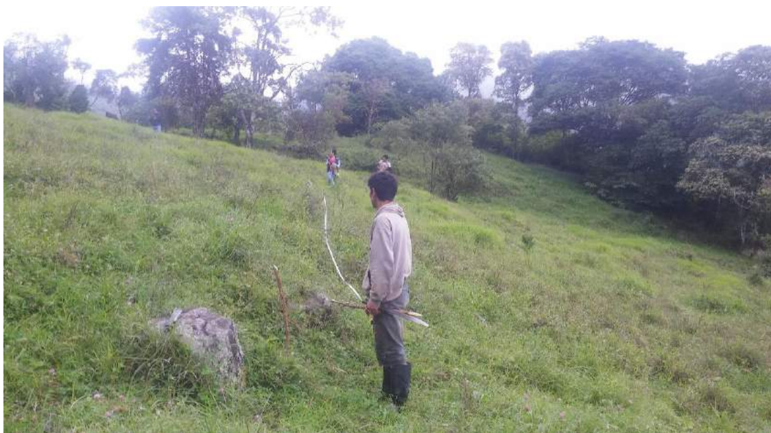
FIGURA N° 76: Estacando las secciones cada 20m y en curva cada 10m
